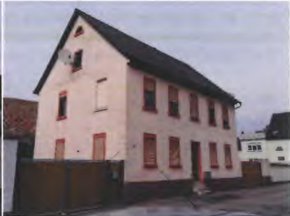
Blick von Südwesten auf das Bestandsgebäude und die seitlichen Toreinfahrten
