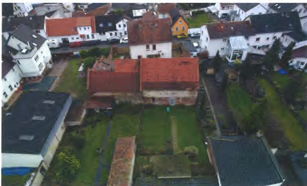
Luftbild von Süden mit Blick über das Plangebiet, die Bestandsbebauung und die umgebende Bebauung (Quelle: Dogan Immobilien- und Vermögensverwaltungs GmbH)
