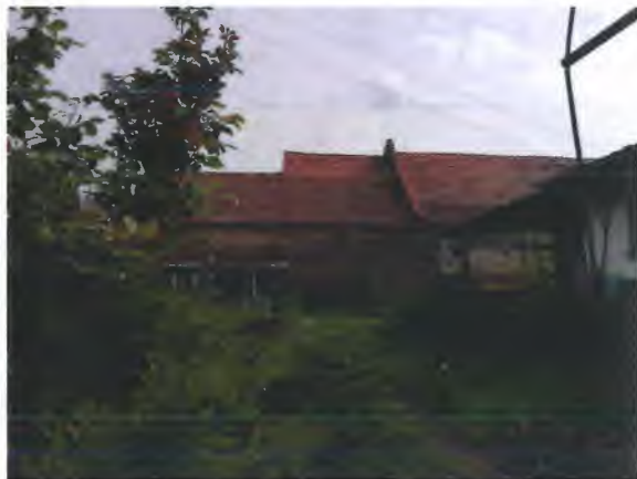
Scheune und Nebengebäude mit anschließendem Gartenbereich von Norden vom Wallgässchen aus gesehen
