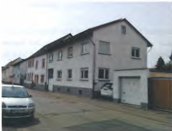
Nachbarbebauung Bleichstraße 32 bis 36
