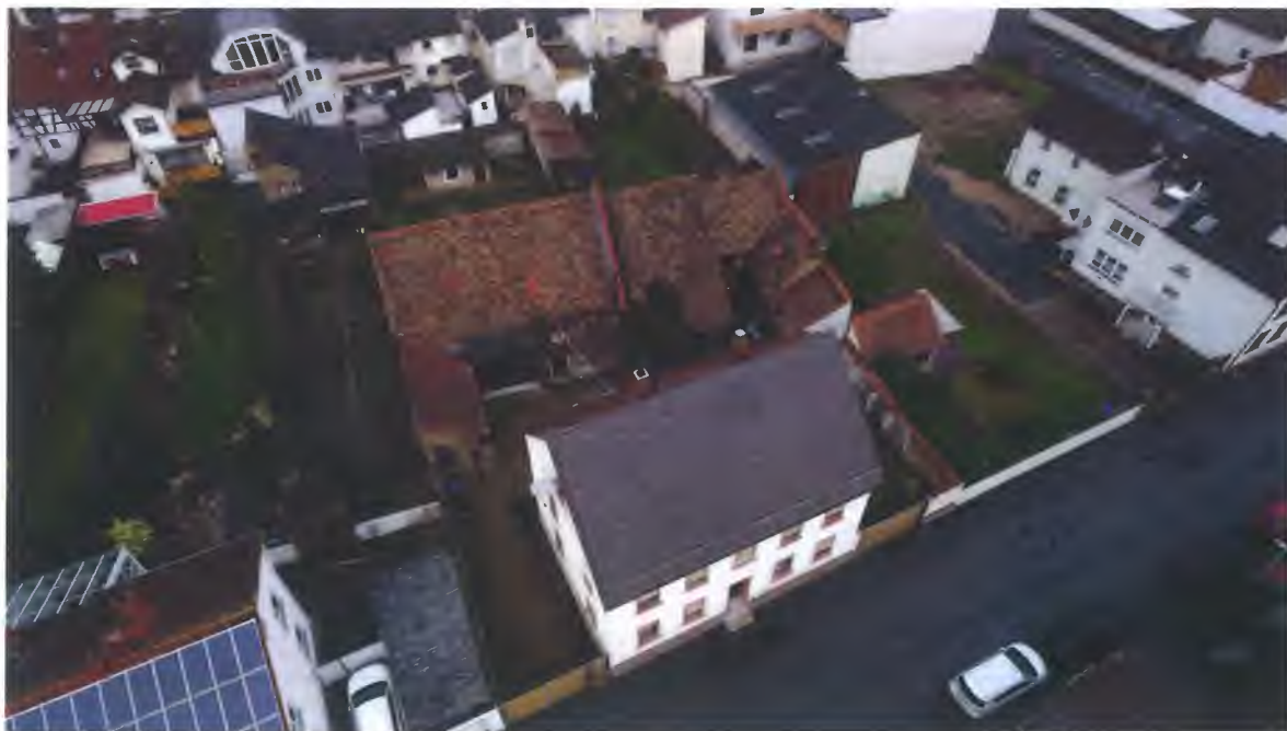
Luftbild von Süden mit Blick über das Plangebiet, die Bestandsbebauung und die umgebende Bebauung (Quelle: Dogan Immobilien- und Vermögensverwaltungs GmbH)
