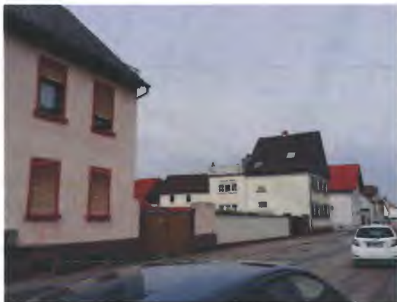
Blick auf Bleichstraße 44 mit Flachdach
