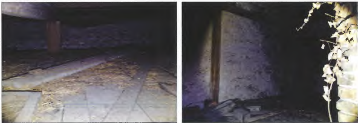
Abb. 13: Der Dachboden konnte aus Sicherheitsgründen nur von den Öffnungen bewertet werden.
