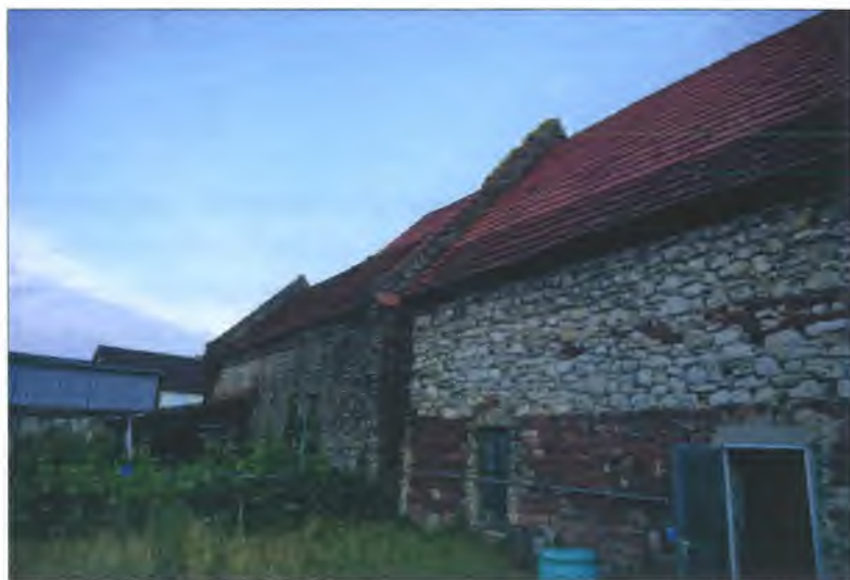
Abbildung 6: Ansicht der Scheune aus dem Garten des Grundstücks.
