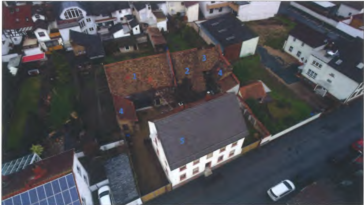
Abbildung 4: Lage der Bestandsgebäude: (Nummern: 1 große Scheune, 2 mittlere Scheune, 3 kleine Scheune, 4 Anbauten, 5 Wohngebäude).
