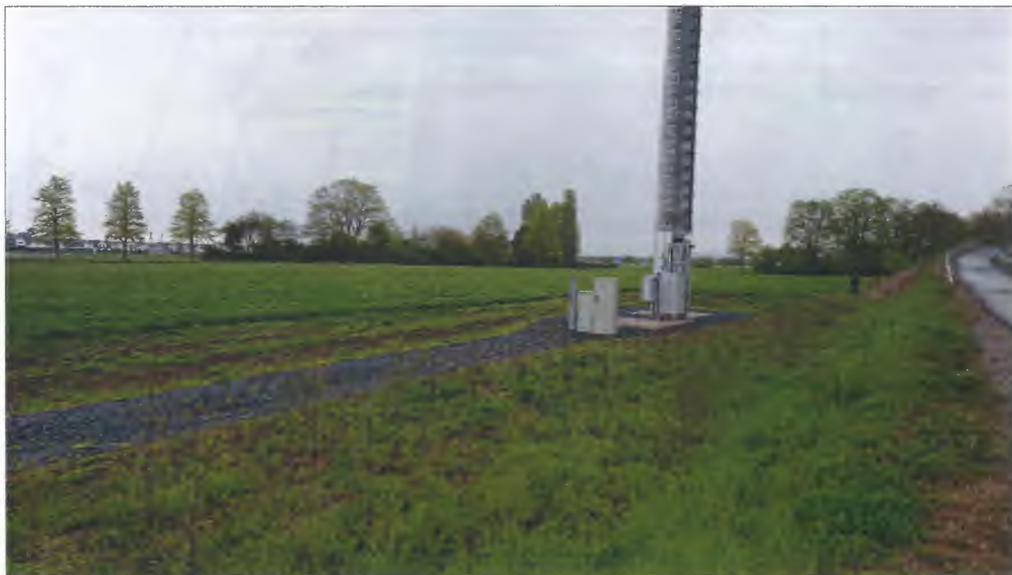
Abbildung 3: Blick von Südwesten in Richtung der Fläche für das Ersatzhabitat. Im Vordergrund ist der Funkmast zu erkennen.
