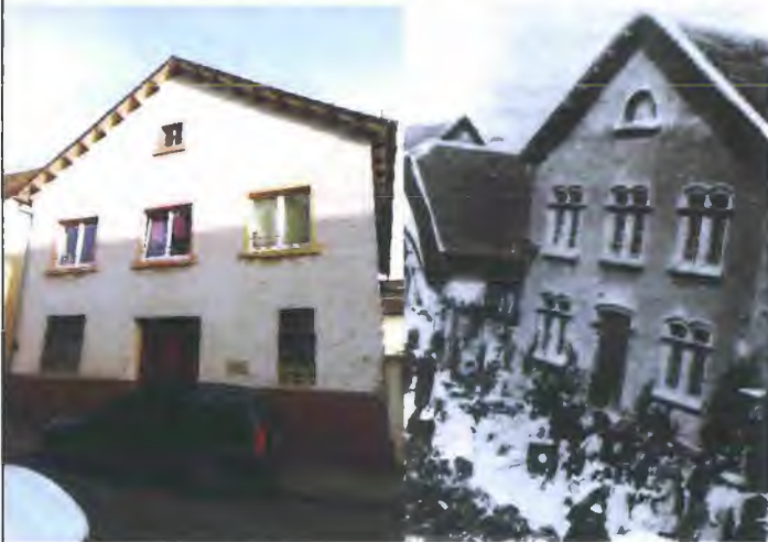
Bestandsgebäude Alte Synagoge (links), Ursprünglicher Zustand (rechts), Schafstraße
