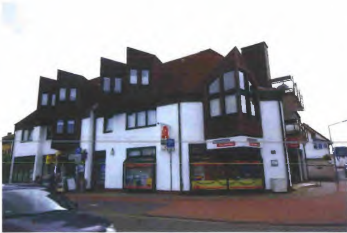
Abbildung 20: Versorgungseinrichtungen an der Karlstraße
