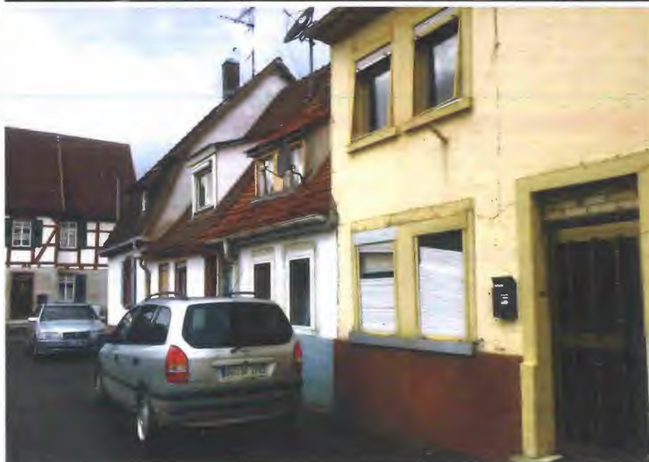
Impressionen Sanierungsbedarf Privatgebäude
