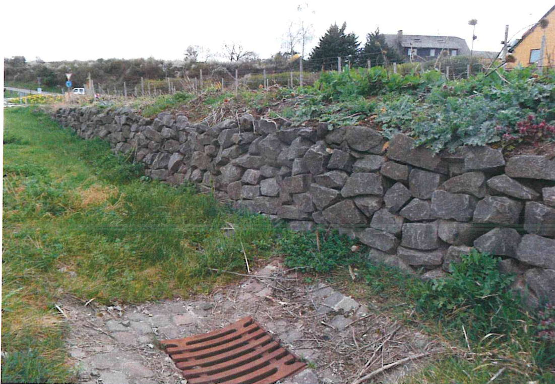
Abbildung 3 Trockensteinmauer unterhalb der Rebzeilen
