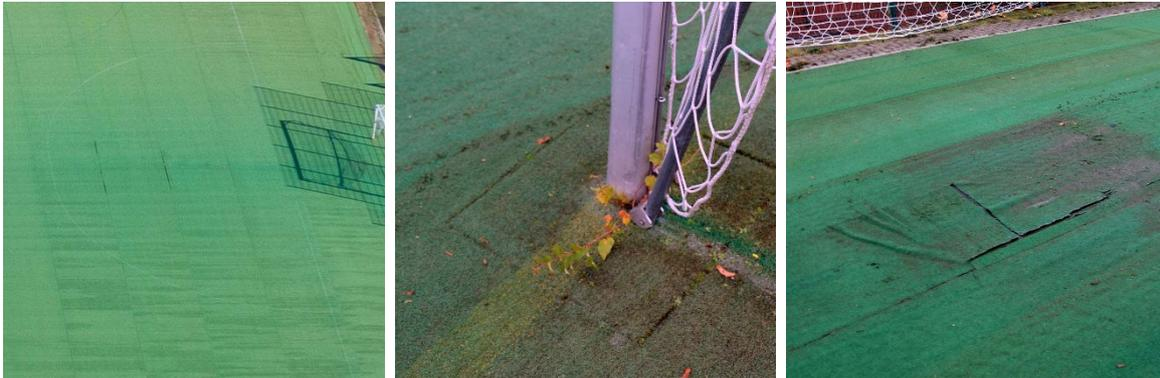
Abb. 8 Offene Längsnähte, Unkrautwuchs auf dem Rasen, aufgerissener Belag
