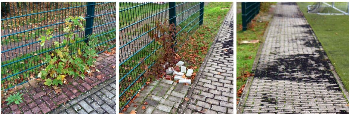
Abb. 6 Büsche sowie Austrag von Granulat beschleunigen den Verfall
