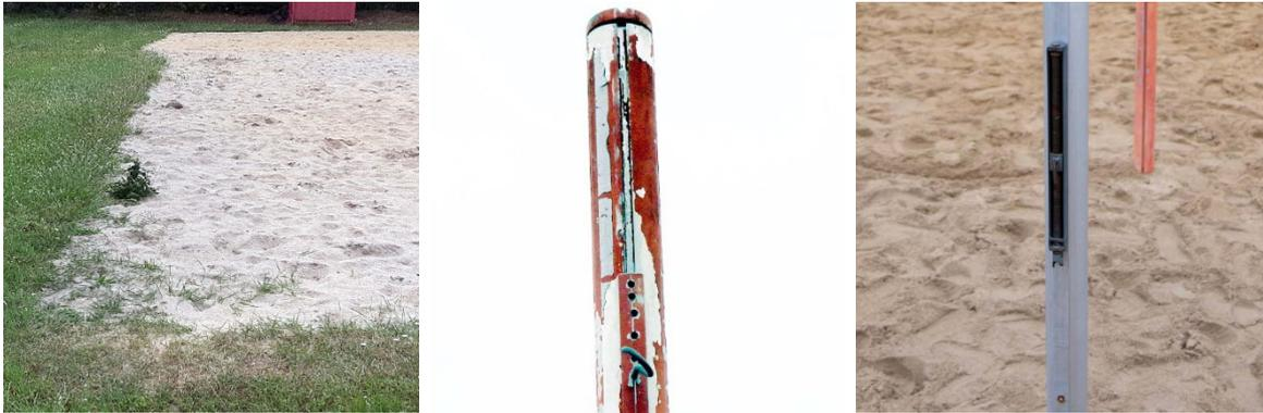
Abb. 16 Unkrautwuchs im Randbereich, defekter Ständer mit zahlreichen ausgefressenen Gewindelöchern, defekter Kurbelmechanismus
