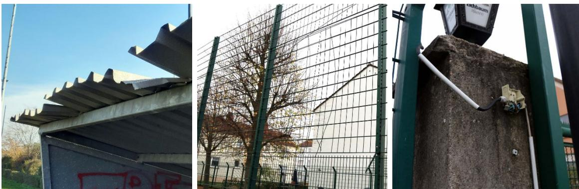
Abb. 7 Sicherheitsrisiko: scharfkantige Stahlbleche in Reichhöhe, fehlende/verbogene Verstrebungen im Ballfangzaun, offenliegende Elektroinstallation
