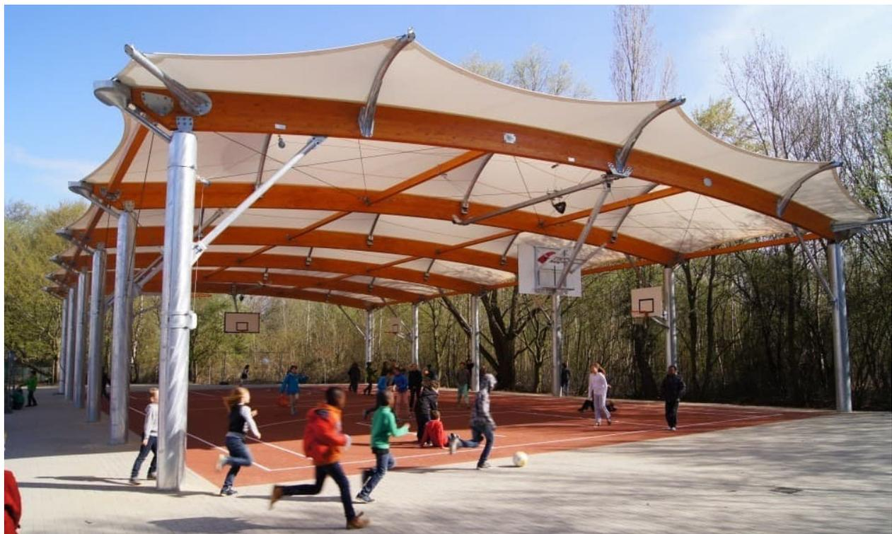
Abb. 43 Stahl-Holzkonstruktion mit lichtdurchlässiger, textiler Membran (© SMC2)
