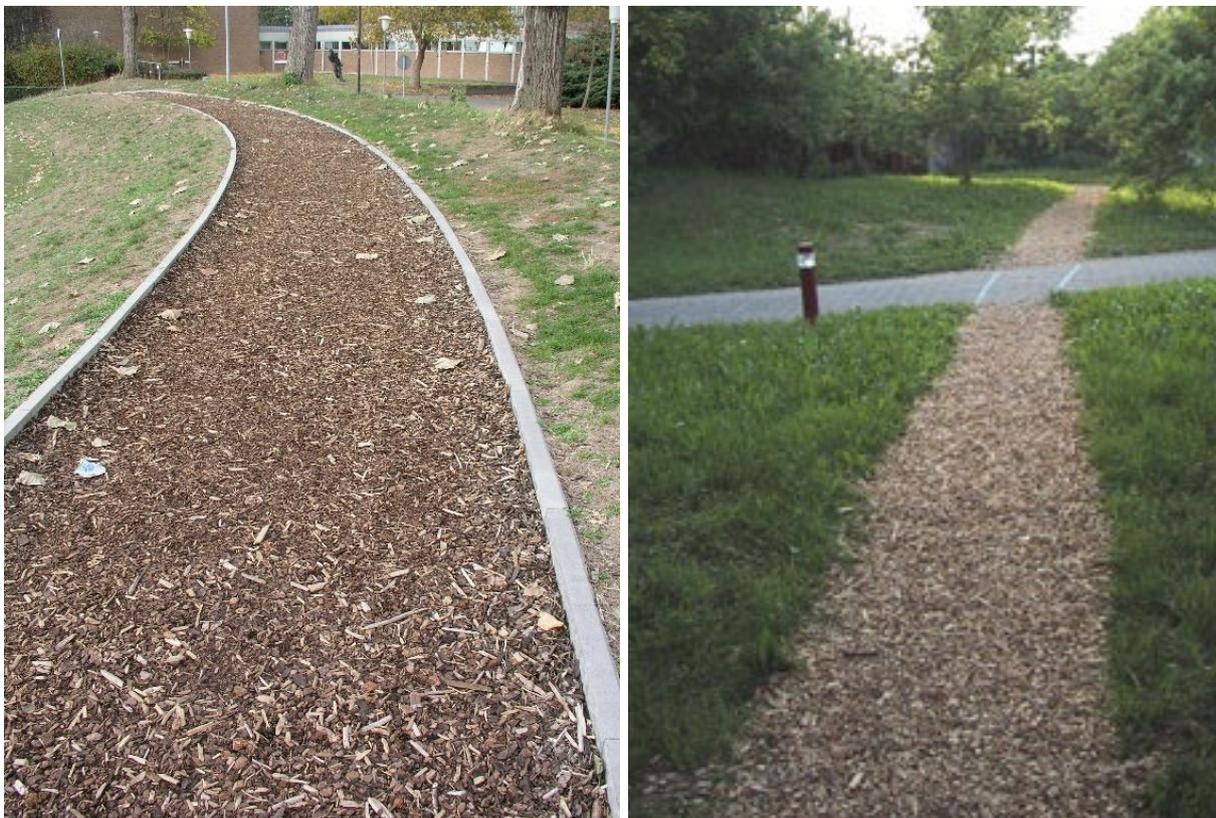
Abb. 98 Finnenbahn im Mainzer Unistadion mit Einfassung durch Rasenkantsteine (links) und Variante ohne Einfassung (rechts)
