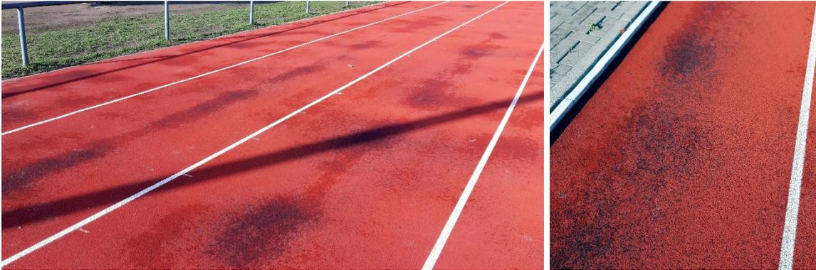
Abb. 10 Abgenutzte Deckschicht
