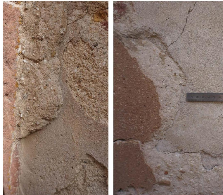
Injektion: Injizierter Restaurationsmörtel sollte nicht nur den Hohlraum füllen, sondern sich mit dem Bestandsputz verbinden.
