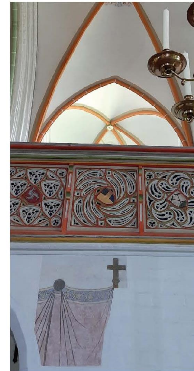
Schlämme/ Tünchen: Auftrag einer Schlämme über Wandmalerei; Beispiel: St. Johanniskirche in Lüneburg
