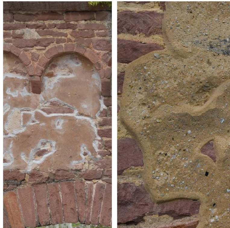
Anböschung: Randanböschungen sind auf die Farbigkeit von salischem Putz (ocker) und gotischem Putz (altrosa) einzustellen:
