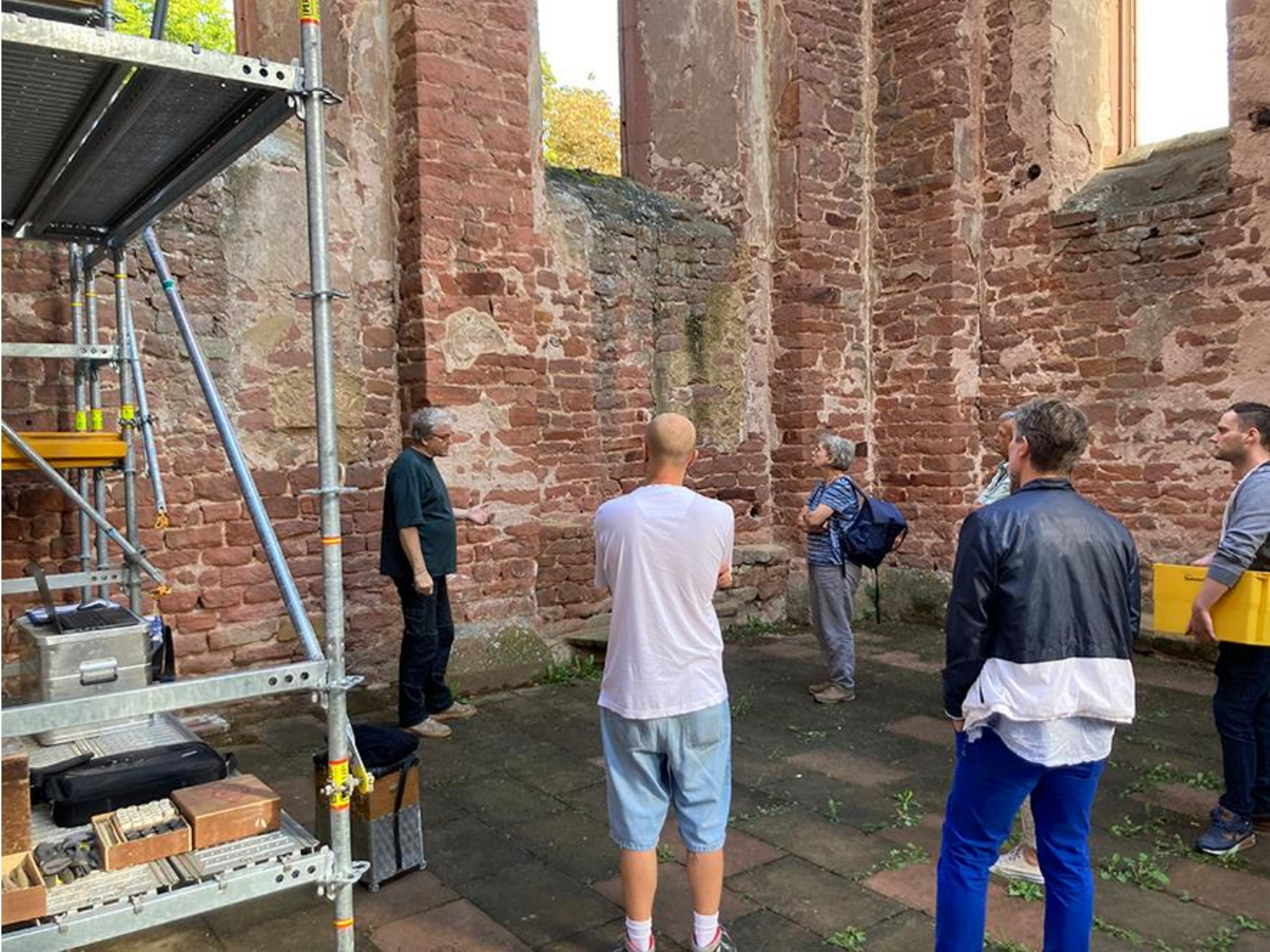
Im Sommer / Herbst 2022 wurde in Abstimmung mit dem IfS Mainz und der GDKE RLP eine erste **Musterfläche** zur Erprobung der Putzsicherungsmaßnahmen angelegt. Der Schwerpunkt lag bei der Putzfestigung, der Randsicherung durch Anböschung und der Hohlstellenverfüllung (siehe Foto).
