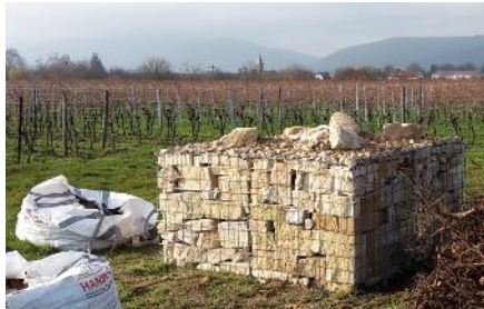
Abbildung 82: Nachträglich (2015) errichtete Gabione bei Mußbach auf einer Ökofläche aus der Flurbereinigung von 1992 172
