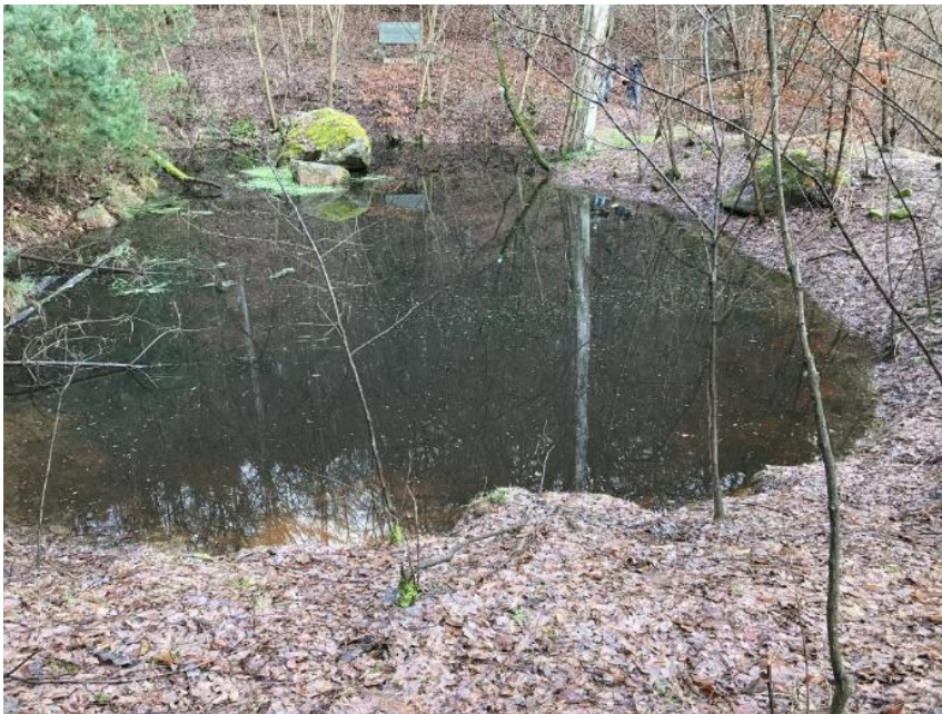
Abbildung 71: Rückhaltebecken am Weinbiet-Nordhang. RHB in Trockentälchen im Wald halten Sturzfluten zurück und können sich zu interessanten Biotopen entwickeln, wie hier ein Mitte der 1980-er Jahre angelegtes Becken (Zustand Januar 2022) 151
