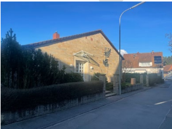
Abbildung 10: Prot. Gemeindehaus (eigene Aufnahme, 2023)
