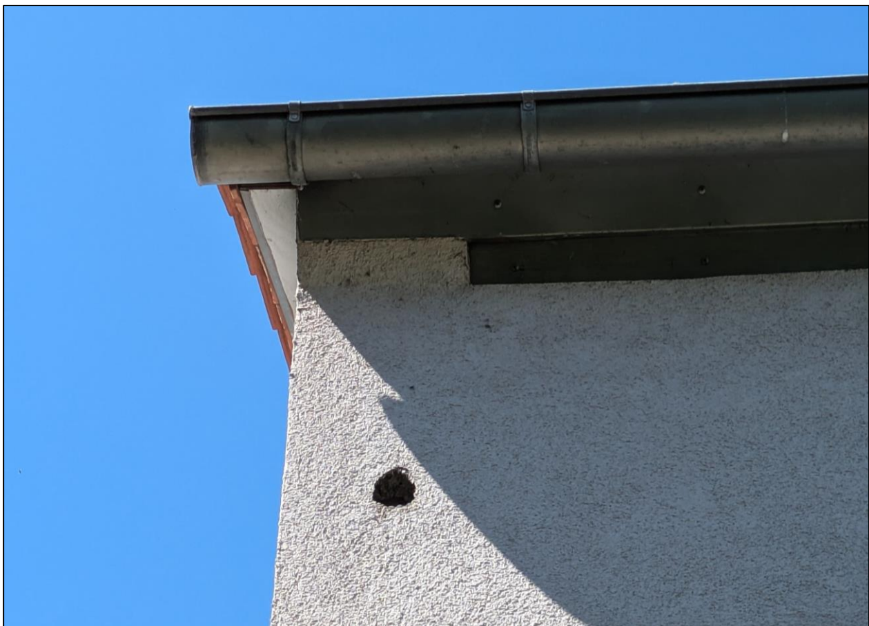
Abb. 6: Loch in der Fassade eines Bestandgebäudes (Foto: P. Kues)
