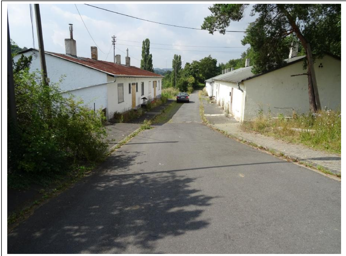
Noch vorhandene Gebäude ohne Einflugmöglichkeiten für Fledermäuse
