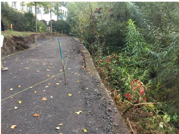
Bild Nr. 2: Verlauf der „deformierten“ Trockenmauer
