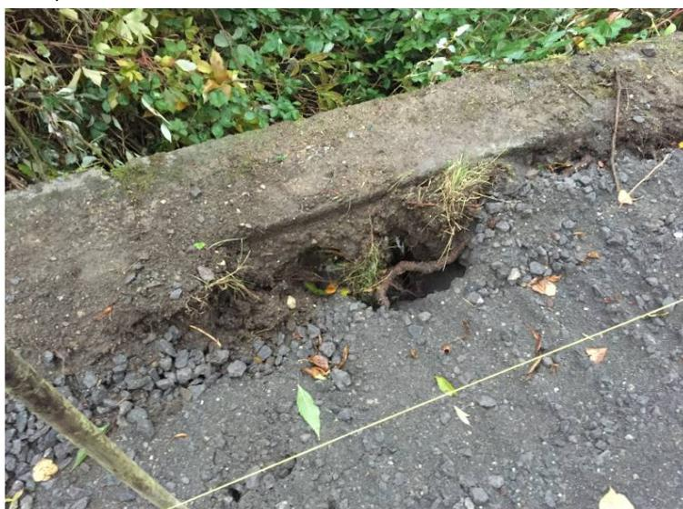
Bild Nr. 1: Freigelegte Trockenmauer mit „Fehlstellen“ und „Deformationen“
