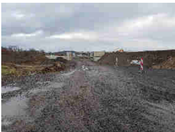
Abbildung 11: vorhandene Bebauung im Plangebiet Zufahrt zu Fläche eines Tiefbauunternehmens
