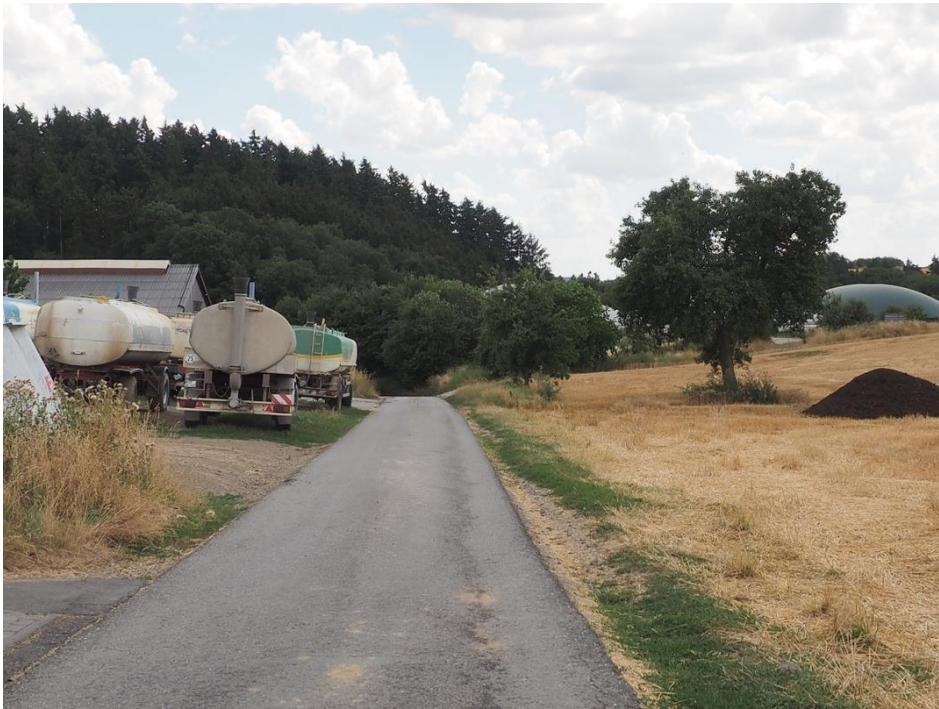
Abbildung 6: bituminös befestigter Erschließungsweg zur Biogasanlage
