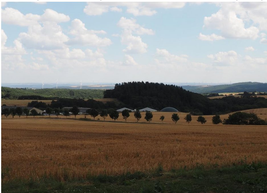
Abbildung 5: Blick auf die Anlage von der B 258
