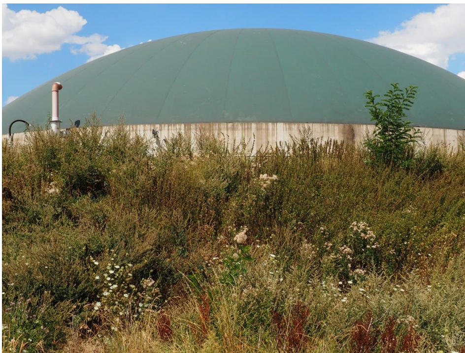
Abbildung 10: Blick auf die randliche Eingrünung der Gärbehälter 3
