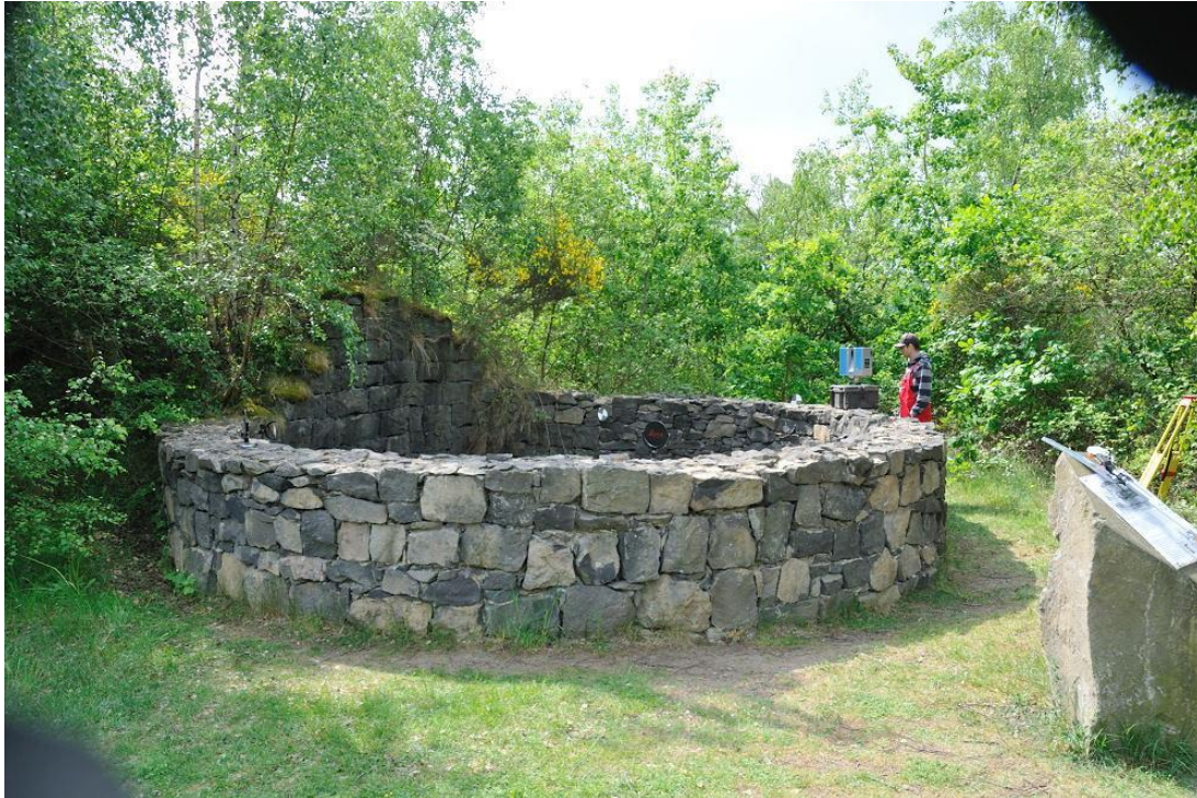
Abb. 13: Aufgemauerter und gesicherter Schacht im Teilgebiet Mayen.
