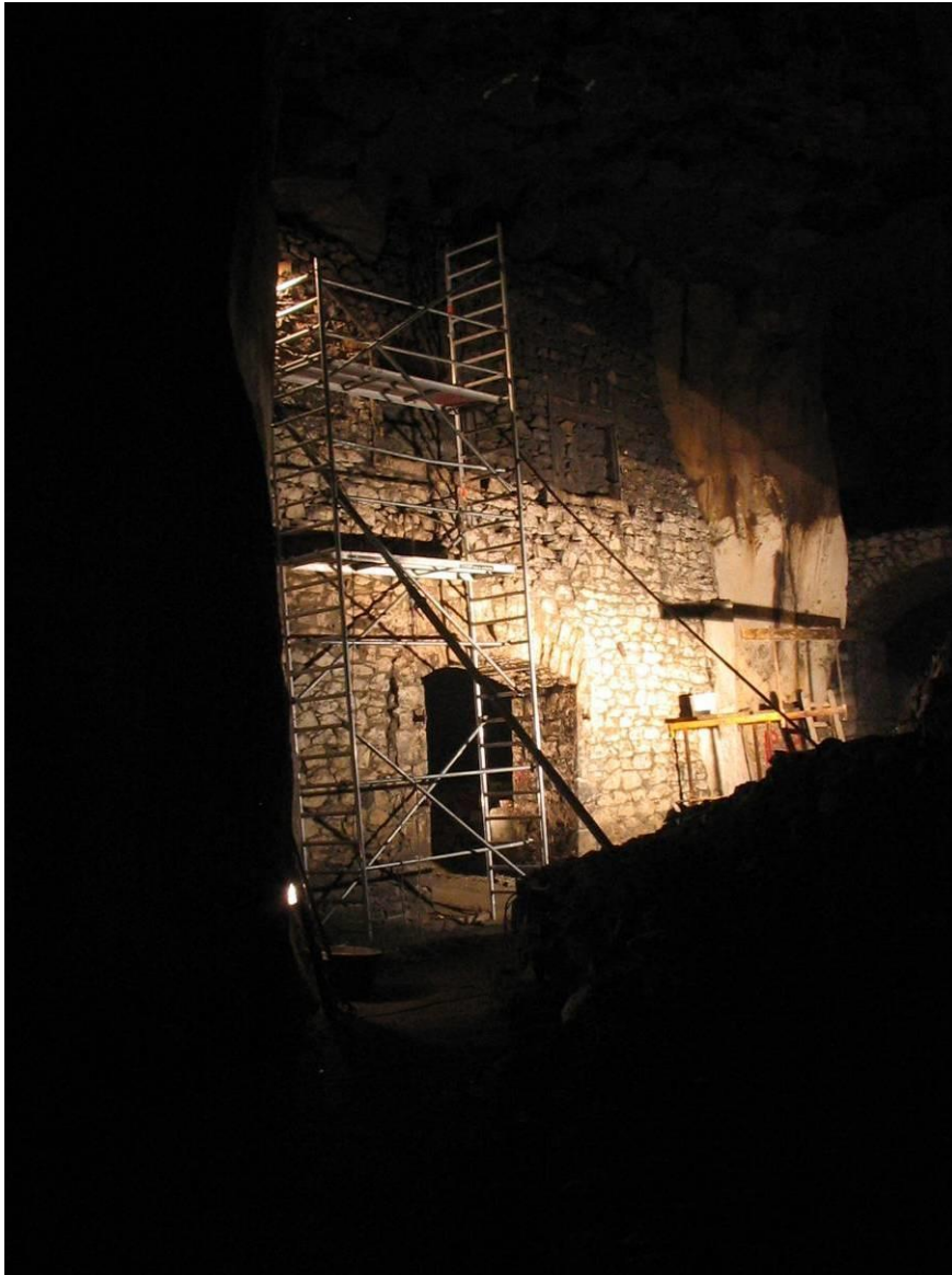
Abb. 2: Sicherungsmaßnahme im Bereich des Lava-Kellers im Januar 2008. In Mauerspaltten dieses Torbogens wurden in den Jahren zuvor immer Fledermäuse angetroffen.
