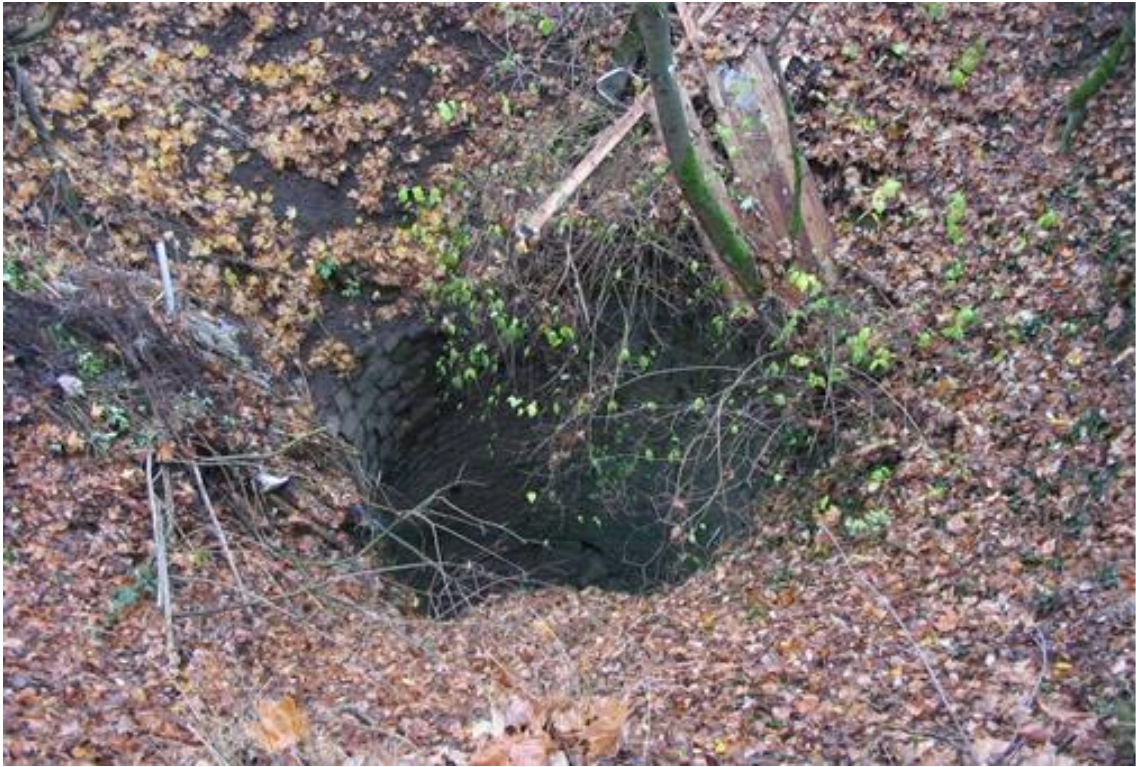
Offener Schacht des Stollenabschnitts „Teddy“ in Niedermendig. Die Schächte sind mehr als 25 m tief und oftmals nur durch einen Zaun gesichert.
