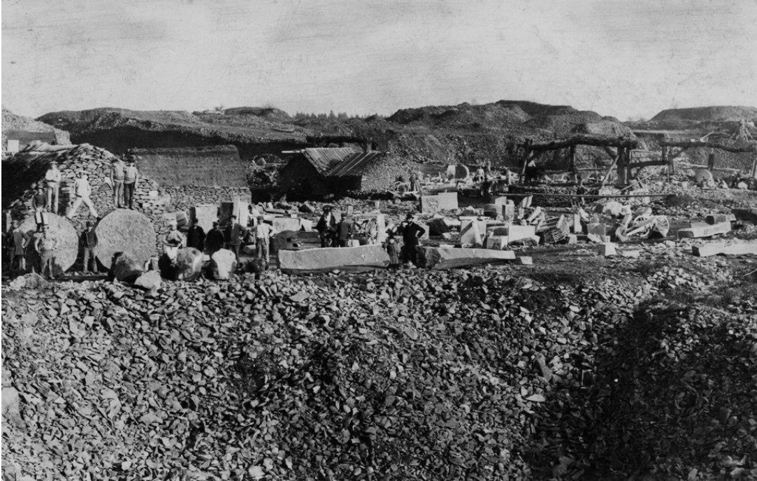
Abb. 6: Typische Szene des Mayener Grubenfeldes um 1900. Erkennbar mehrere alte Göpelkräne zur Förderung der Steine. Daneben einfache, strohgedeckte Hütten der Steinmetze. Im Hintergrund die Halden (Rötschen) des Altbergbaus. Foto Böhm um 1900. GAV Mayen.
