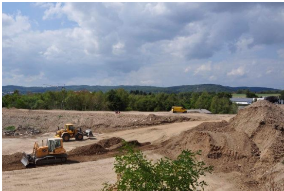
Abbildung 16: Blick auf aufgefüllte Flächen im mittleren Bereich des Plangebiets (August 2018)
