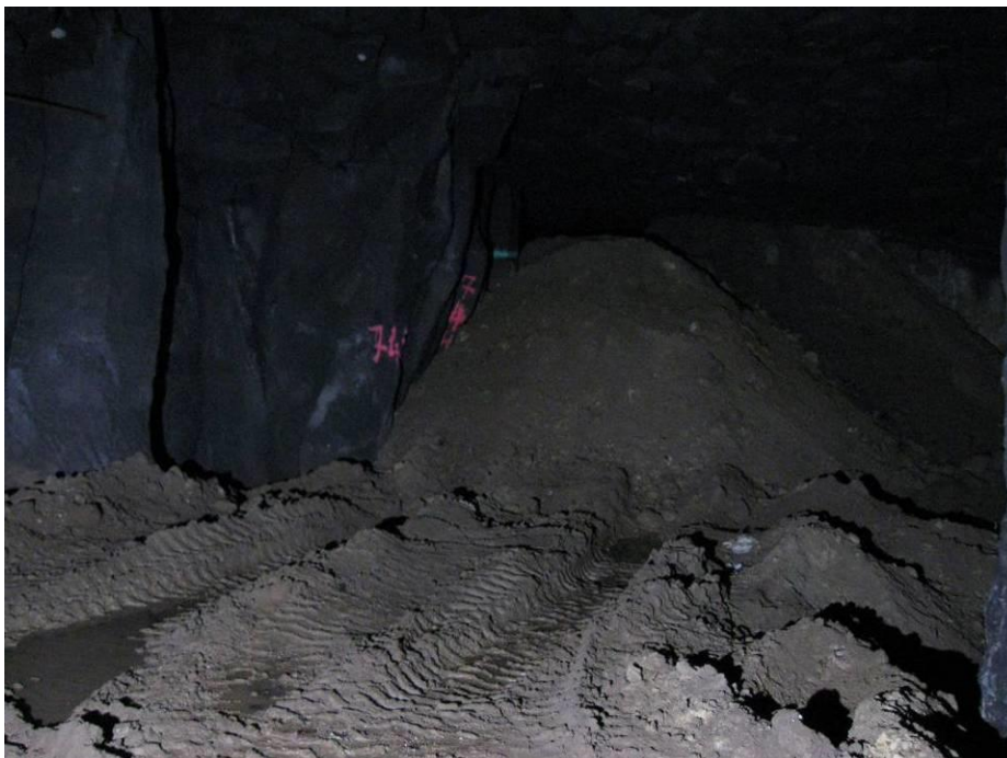
Abb. 4: Erdverfüllung im südlichen Bereich des Hauptsystems.
