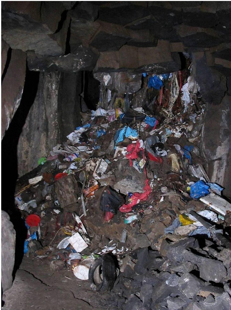
Abb. 3: Müllschacht Nr. 18 im Abschnitt M des Hauptsystems der Brauerstraße. Maßnahme S11.
