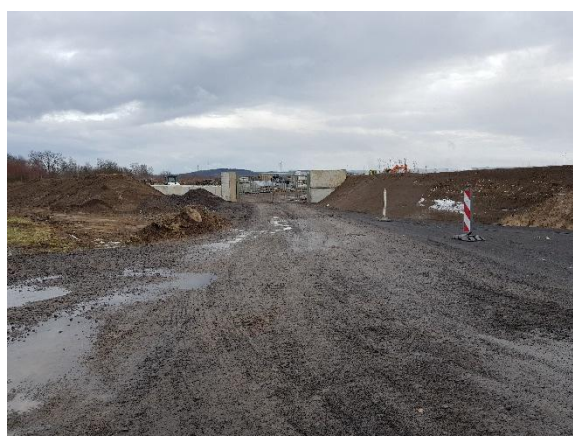
Abbildung 11: vorhandene Bebauung im Plangebiet Zufahrt zu Fläche eines Tiefbauunternehmens
