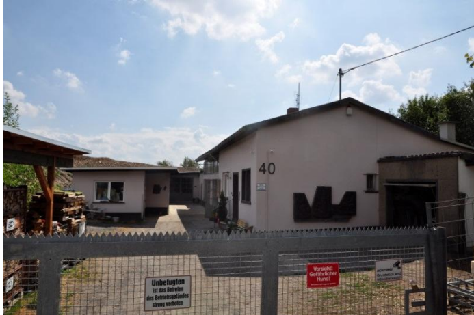
Abbildung 17: Gebäude innerhalb der ehemaligen Betriebsflächen
