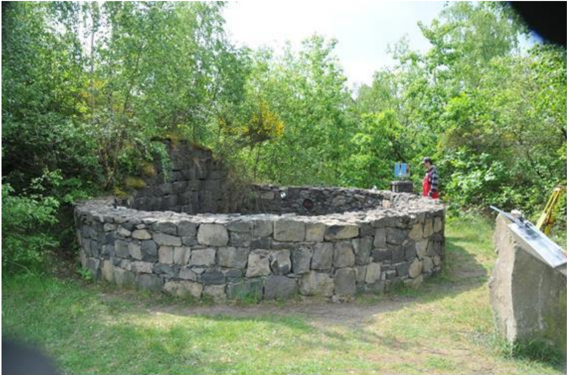
Abgesicherter Schacht im Mayener Grubenfeld. In diesem Teilgebiet werden im Rahmen des Naturschutzgroßprojektes alle offenen Schächte aufgemauert und stabilisiert.
