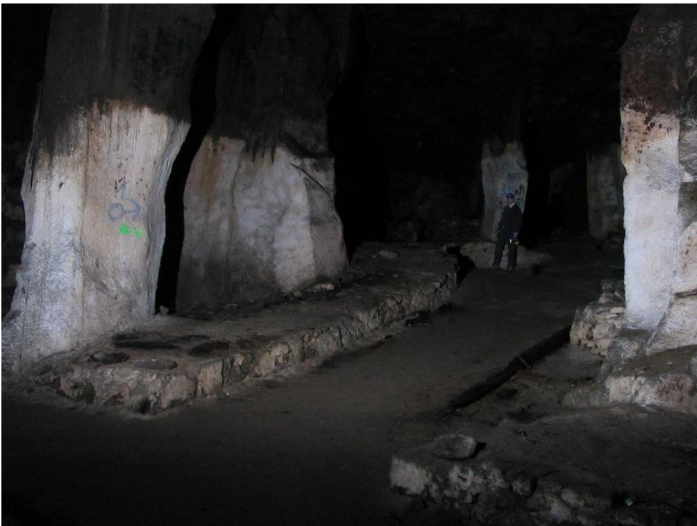
Abb. 10: Typischer Bierkeller in Niedermendig: die Räume sind vom Schutt freigeräumt und zwischen 6 – 8 m hoch.
