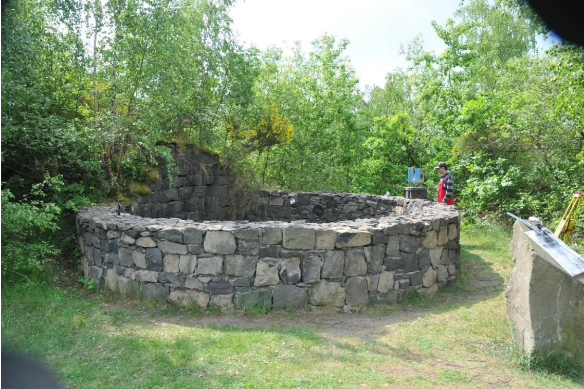
Abb. 13: Abgesicherter Schacht im Mayener Grubenfeld. In diesem Teilgebiet werden im Rahmen des Naturschutzgroßprojektes alle offenen Schächte aufgemauert und stabilisiert.
