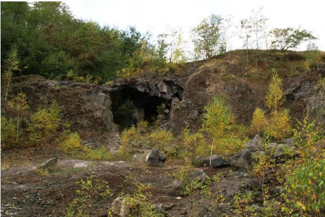
Abb. 12: Grube Stürmerich in Niedermendig. Hier ein angeschnittener Eingang zu dem Stollensystem.
