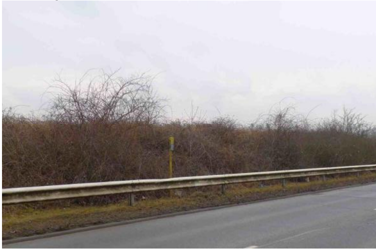
Abbildung 20: Gebüschstreifen in Höhe des Bauhofs:
