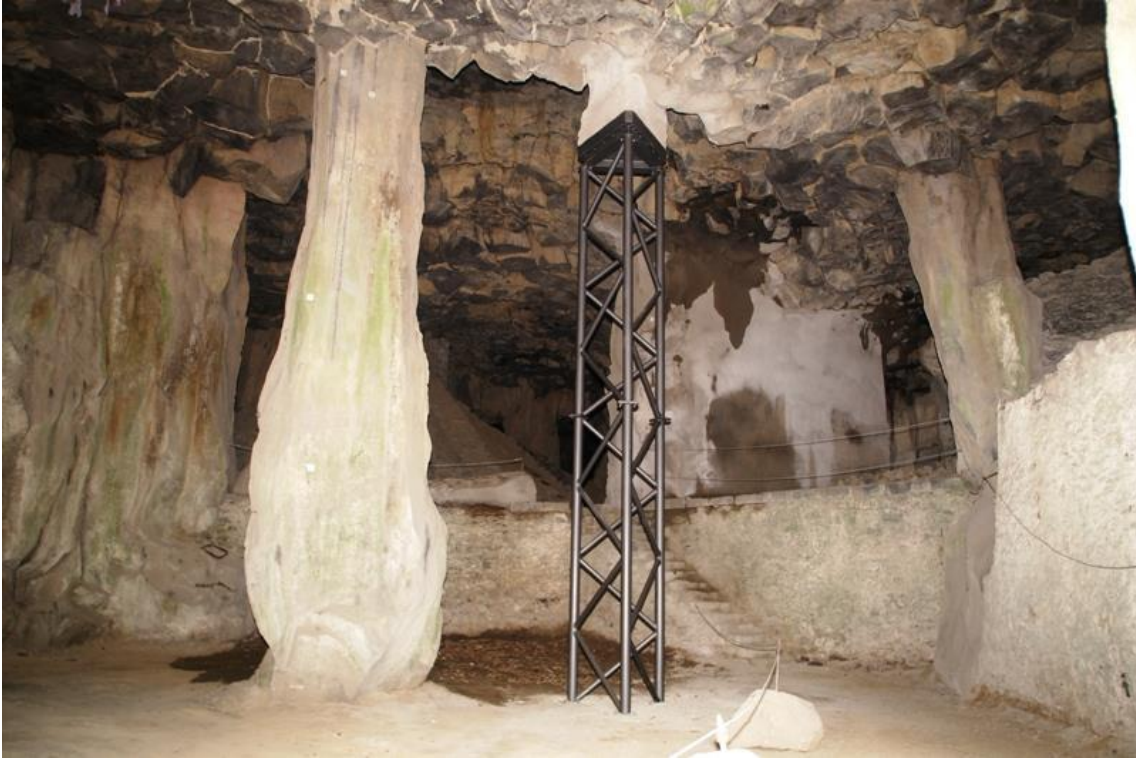
Abb. 17: MAYKO-Bierkeller im Mayener Grubenfeld. Die Stahlsäule (ca. 10 m hoch) und die dahinter befindliche Betonsäule wurden im Rahmen des Naturschutzgroßprojektes als Sicherungsmaßnahme eingebaut.
