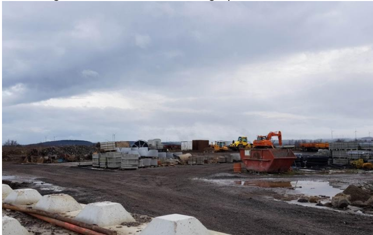
Abbildung 18: Blick auf den Lagerplatz/ Bauhof:
