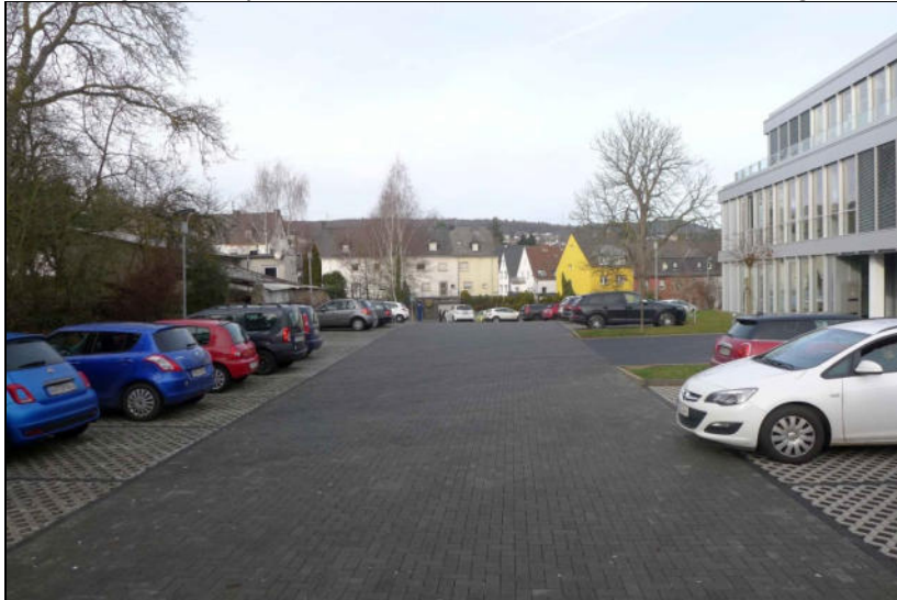
Abbildung 12: Stellplätze, Zufahrt und Ärztehaus im rückwärtigen Grundstücksbereich
