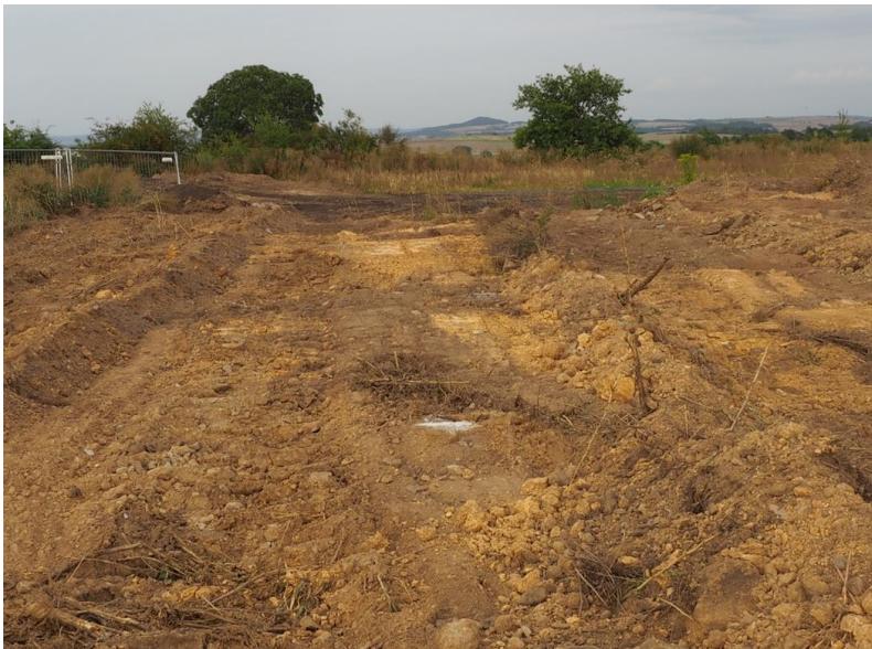
Abbildung 6: Vorbereitung neuer Lagerflächen
