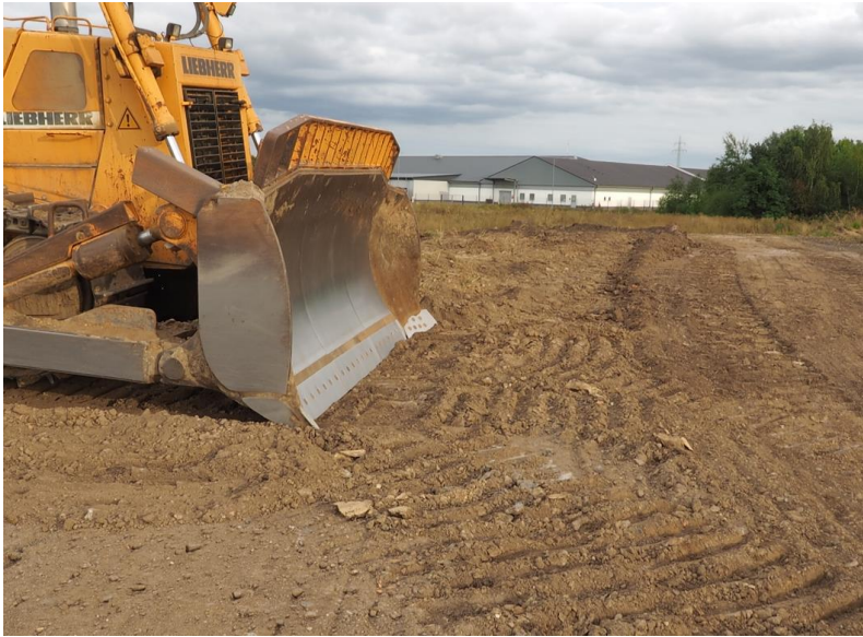
Abbildung 7: Vorbereitung neuer Lagerflächen
