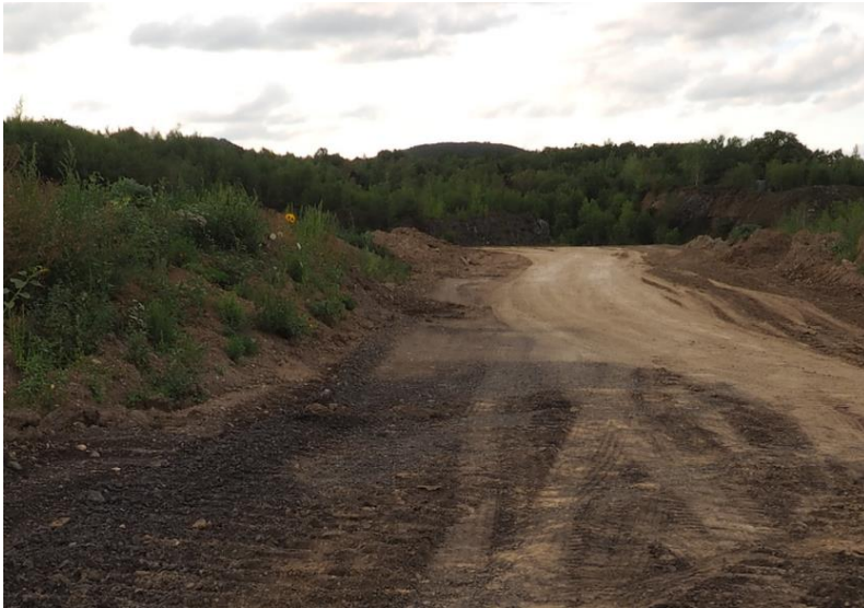
Abbildung 9: Baustraßen mit Ruderalvegetation im Böschungsbereich
