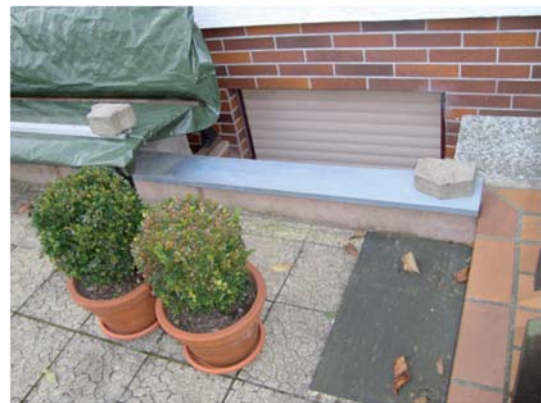
Abbildung 17: Mauer vor Kellerfenster
