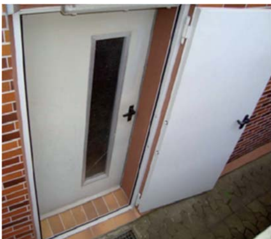
Abbildung 18: Nachträgliche Einbauten an Tür und Kellerfenster zum Schutz gegen eindringendes Wasser
