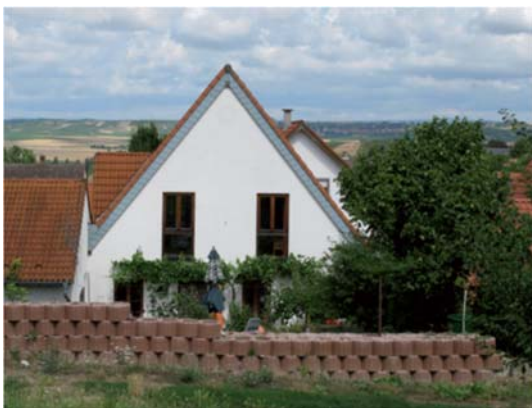
Abbildung 16: Mauer zum Schutz von Außengebietswasser
