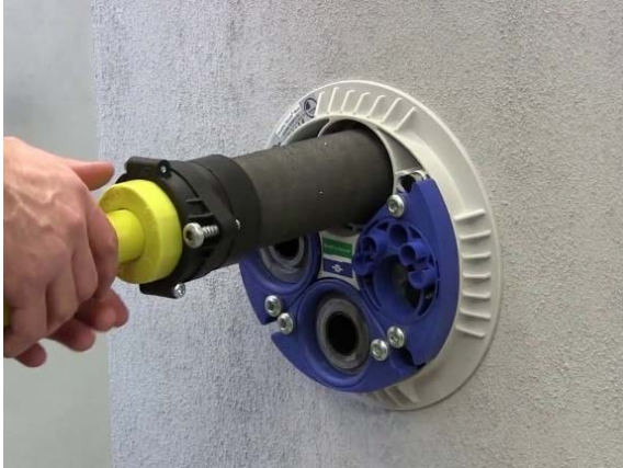
Abbildung 22: wasserdichte Leitungsdurchführung
