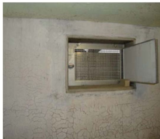
Abbildung 18: Nachträgliche Einbauten an Tür und Kellerfenster zum Schutz gegen eindringendes Wasser
