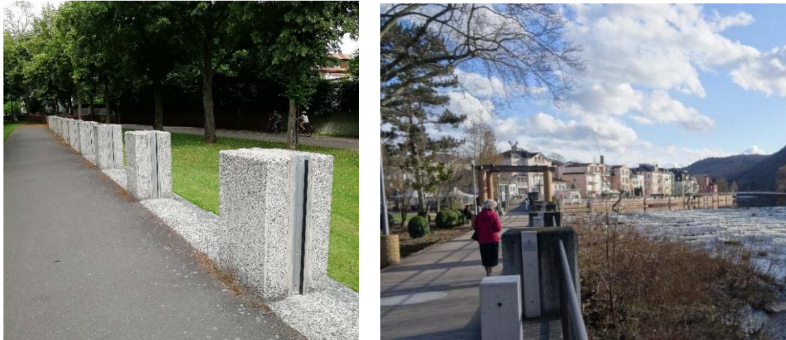
Abbildung 2: Beispiele für mobilen Hochwasserschutz in Bad Kreuznach
