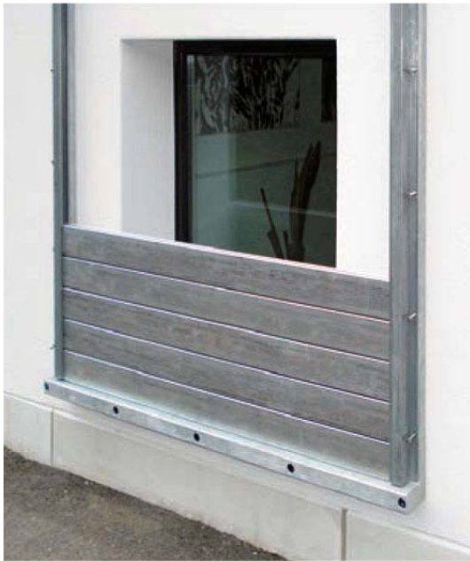
Abbildung 19: Mobile Einbauten vor Fenstern und Türen zum Schutz gegen eindringendes Wasser
