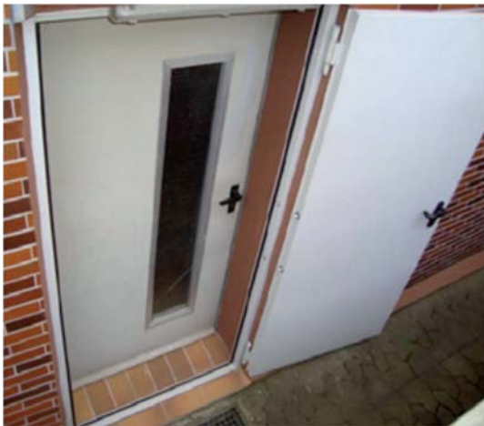
Abbildung 18 - 19 Nachträgliche Einbauten an Tür und Kellerfenster zum Schutz gegen eindringendes Wasser
