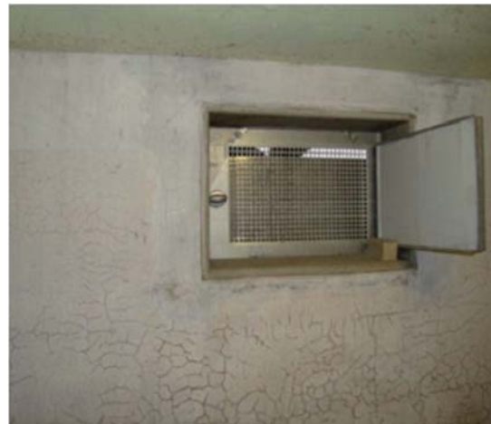
Abbildung 18 - 19 Nachträgliche Einbauten an Tür und Kellerfenster zum Schutz gegen eindringendes Wasser
