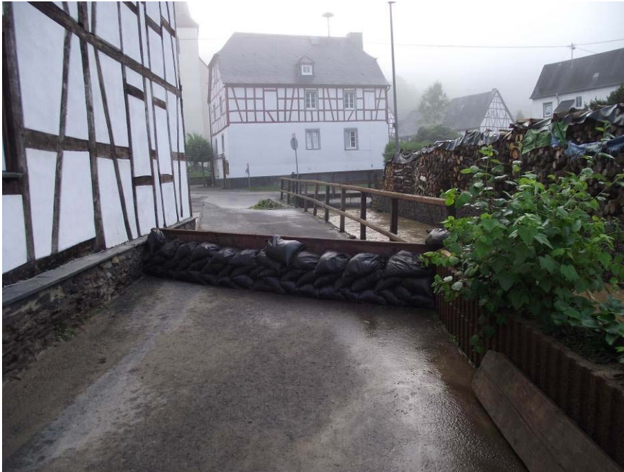
Abbildung 23 Dammbalken mit Sandsäcken
