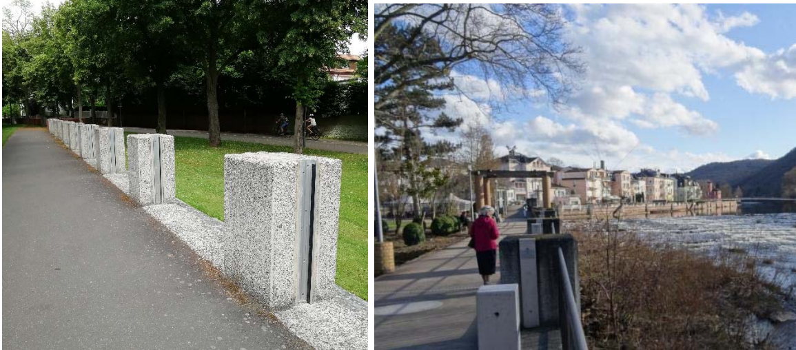
Abbildung 4 Beispiele für mobilen Hochwasserschutz in Bad Kreuznach
