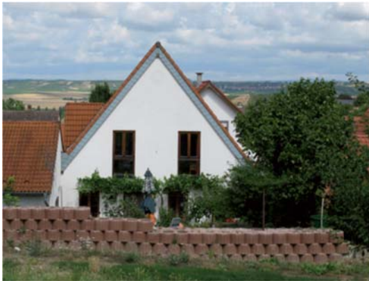
Abbildung 16 Mauer zum Schutz Vor Außengebietswasser
