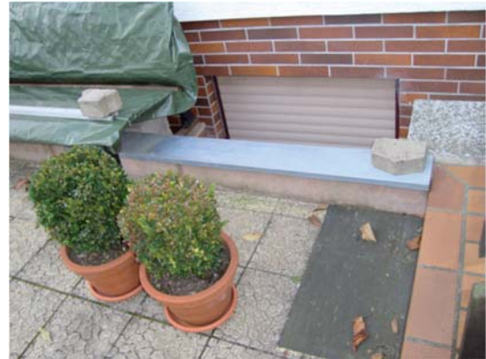
Abbildung 17 Mauer vor Kellerfenster
