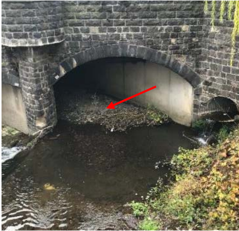
Bild 29: Mayen 13, Bypass räumen
