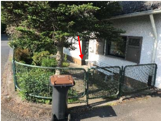
Bild 36: Nitztal 14, tiefliegender Hauseingang
