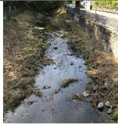
Bild 45: Nitztal 9, Bewuchs entfernt
