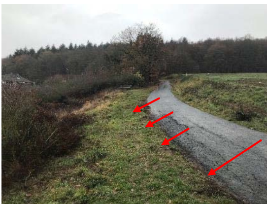
Bild 32: Mayen 23, Bankett schälen + Querrinne anlegen
