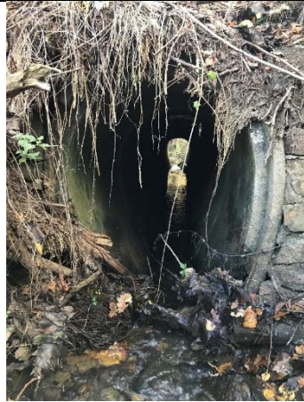
Abbildung 18 defekter Durchlass
