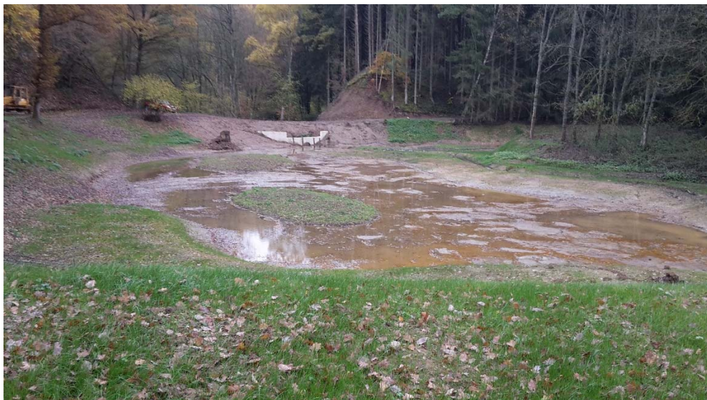
Abbildung 42 Hergestelltes Drosselbauwerk mit Feuchtbiotop bei Station 2+100
