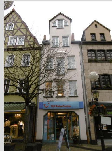
Am Brückentor 7 und 13
