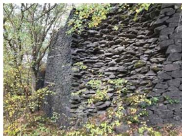
Abb. 70: Sockel eines Grubenkrans im Ettringer Lay. Foto: H. Albrecht (2018).
