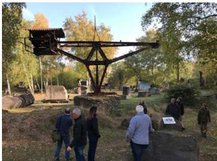
Abb. 48: Grubenkran alter Bauart im Grubenfeld Mayen. Foto: H. Albrecht (2018).
