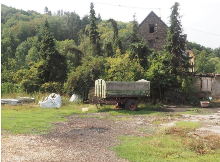
Abbildung 9: Wohngebäude mit Nutzgarten, Gehölzen und Lagerflächen
