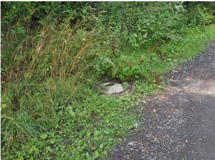
Abbildung 13: Kanalleitung im Bereich des Weges parallel der Nette
