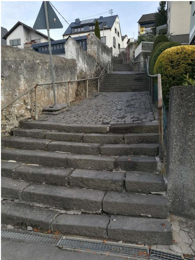
Im Zuge der Sanierung sollen die unterschiedlichen Setzungen in den Teilbereichen behoben werden. Ebenfalls soll die Kastenrinne erneuert werden und die vorhandenen Schachtabdeckungen ausgetauscht werden.
