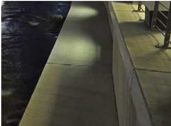
Ufermauer in Sichtbeton
