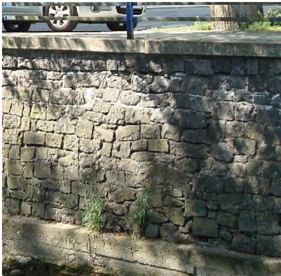
Ufermauer mit Basaltverkleidung
