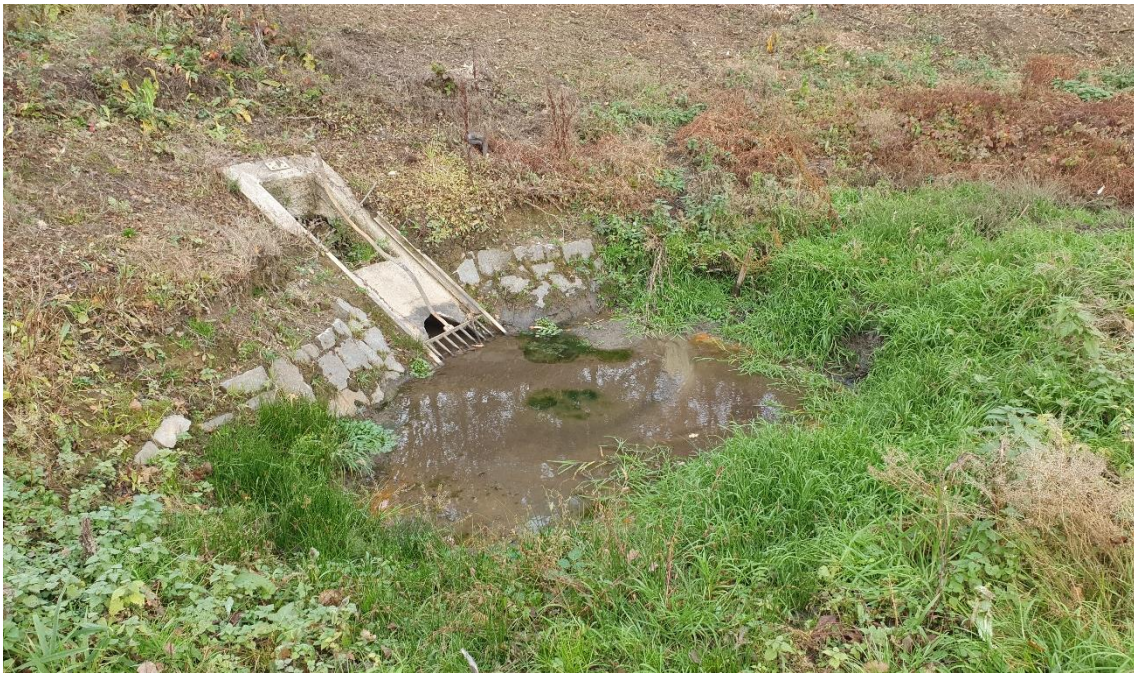
Abb. 2: Einlaufbauwerk Vorbecken
