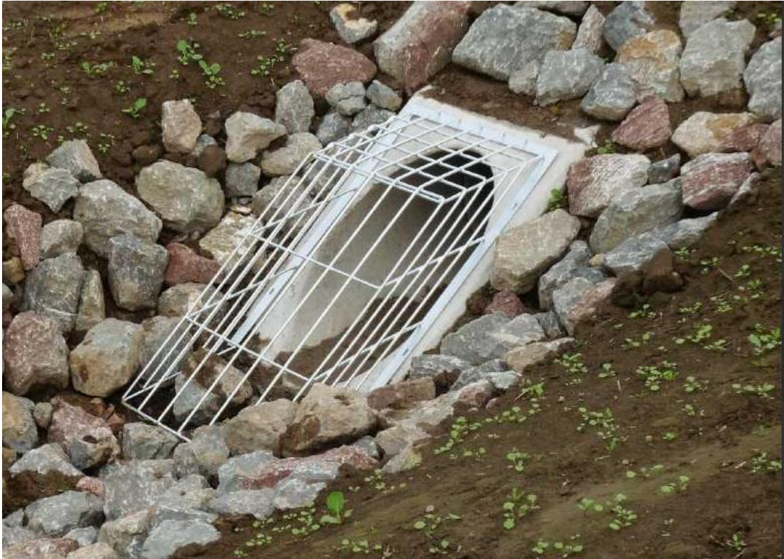
Abb. 6: Beispiel Rechen für Vorbecken (Quelle: KLAT Systeme)
