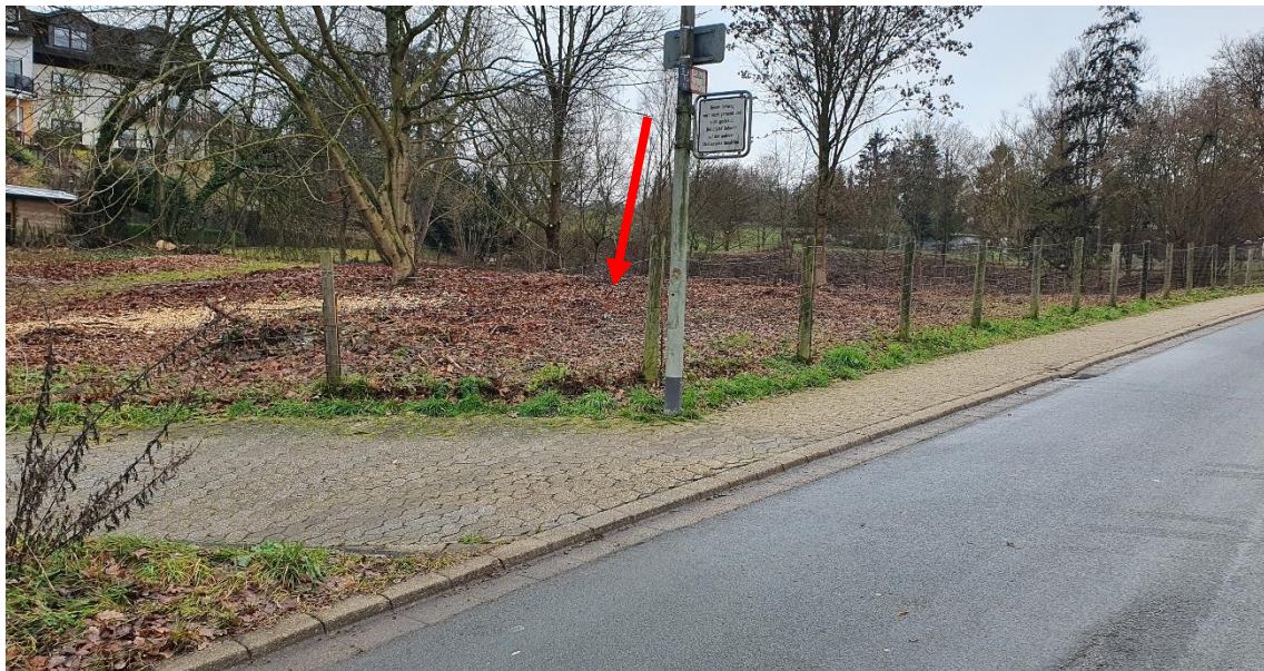
Abb. 5: Bereich Notentlastung Feuchtbiotop-Becken
