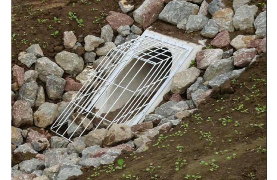
Beispiel Rechen für Vorbecken (Quelle: KLAT Systeme)
