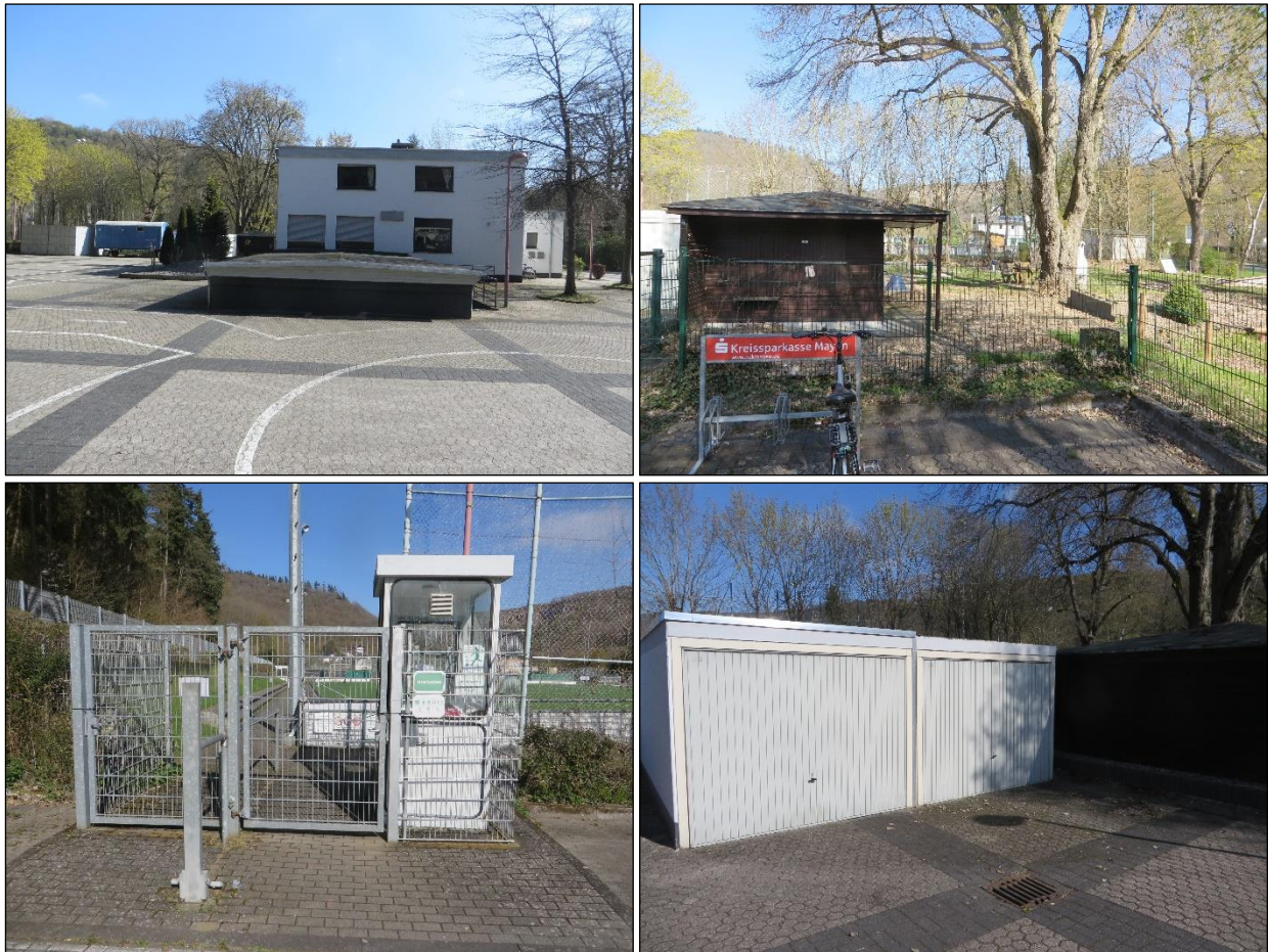
Abbildung 5: Blick nach Nordosten auf die Südwestseite des Schützenhofes (Foto oben links); Blick nach Nordwesten auf den Golfplatz mit Kassier- und Materialhäuschen (Foto oben rechts); Blick auf das Kassierhäuschen des angrenzenden Stadions (Foto unten links); Doppelgarage nordwestlich des Schützenhofes (Foto unten rechts) (Fotos: GUTSCHKER-DONGUS 2021)
