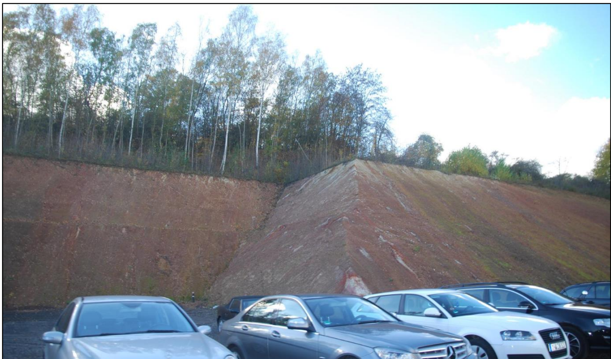
Abbildung 6: Böschungen im Südwesten der Gewerbefläche (Dez. 2020)
