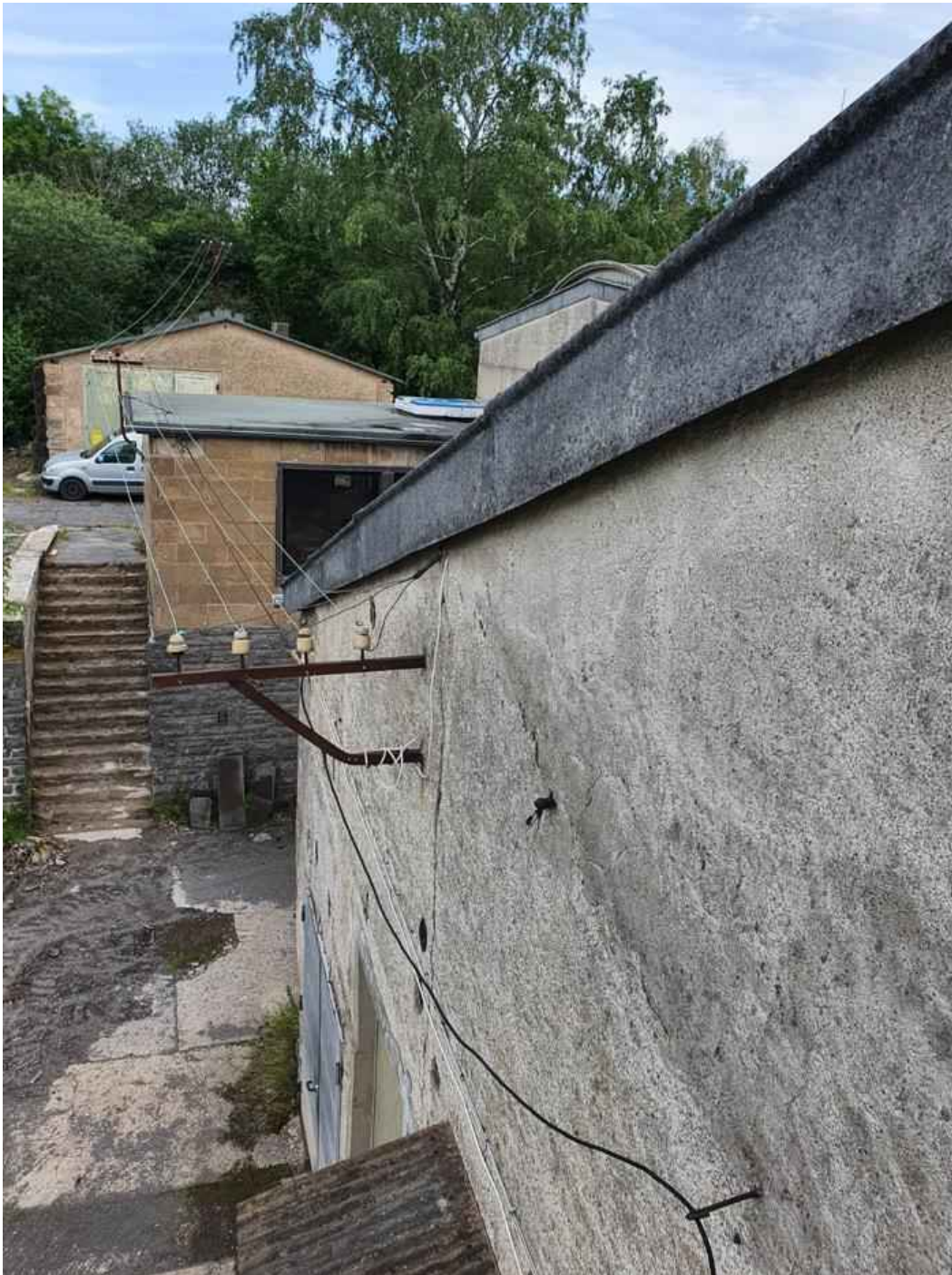
Bild 33: Mittels Hubsteiger konnten die meisten potenziellen Fledermausquartiere gezielt auf eine tatsächliche Nutzung überprüft werden
