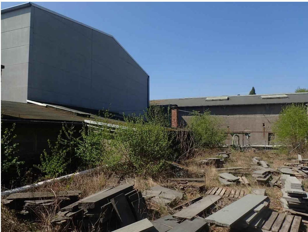
Bild 22: Rückansicht der Gebäude im südlichen Abschnitt
