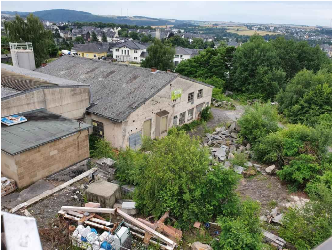
Bild 01: Blick auf den nördlich gelegenen Gebäudekomplex vom Hubsteiger
