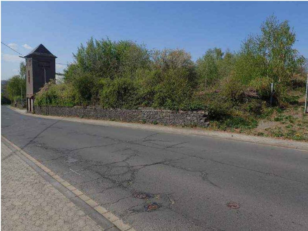
Bild 03: Der Lagerplatz der Basaltlavawerke Hans Schlink KG nördlich des Kottenheimer Weges mit ausgedehnten Sukzessionsgebüsch
