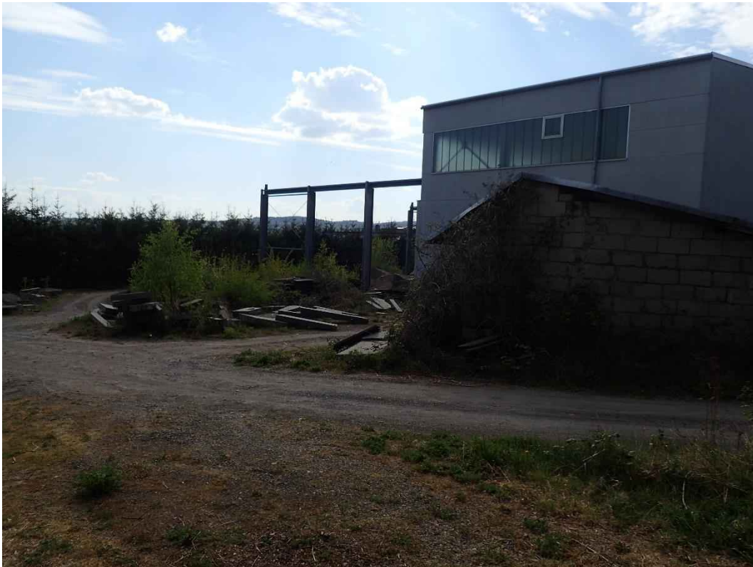
Bild 23: Blick auf die Ostseite des Gewerbegebäudes
