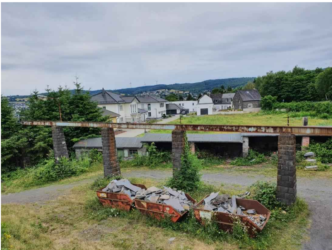
Bild 18: Die alten Schienen des Krans bieten den Vögeln gute Anstanzmöglichkeiten (vom Hubsteiger aus)
