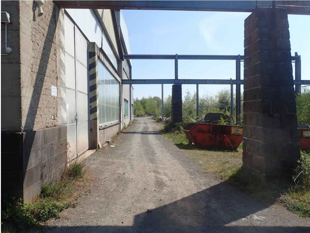
Bild 17: Blick entlang der Betriebshalle im Südosten
