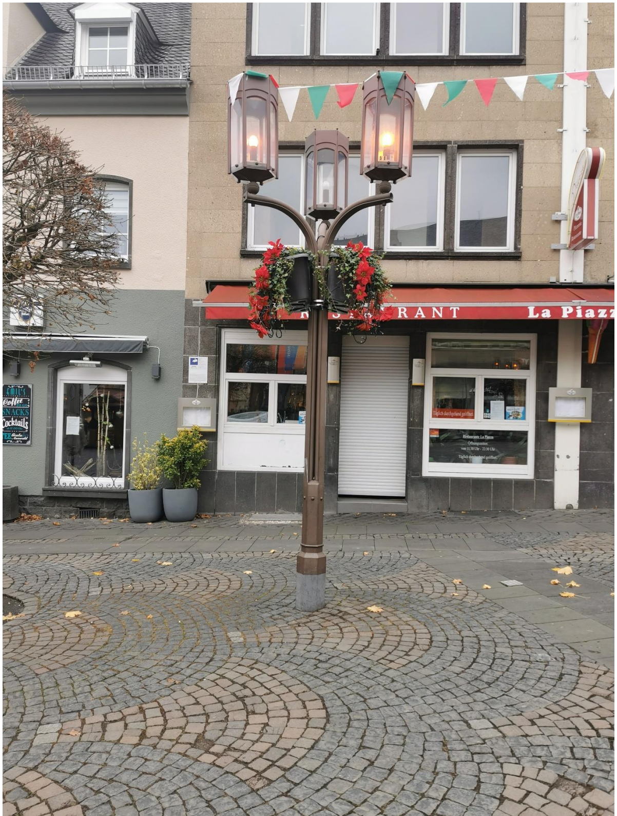
Abbildung 8: Kandelaber mit Natriumdampfampe (entweder eine Leuchte defekt oder in Halbnachtschaltung)
