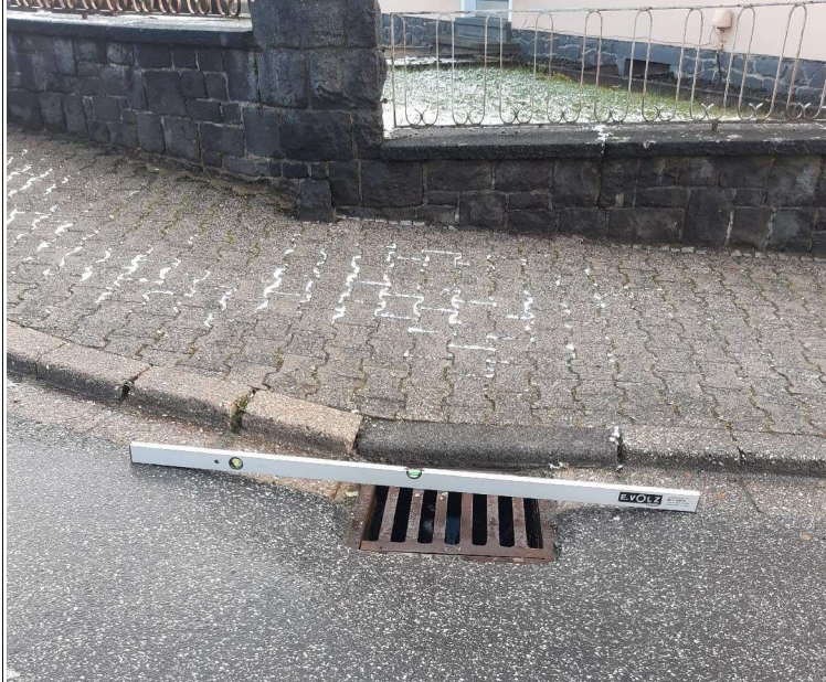
Beispielbild: RE in Asphalt
