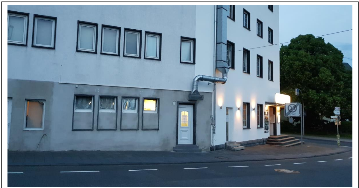
Abb. 4: Bestehende Situation Gastronomiebereich
