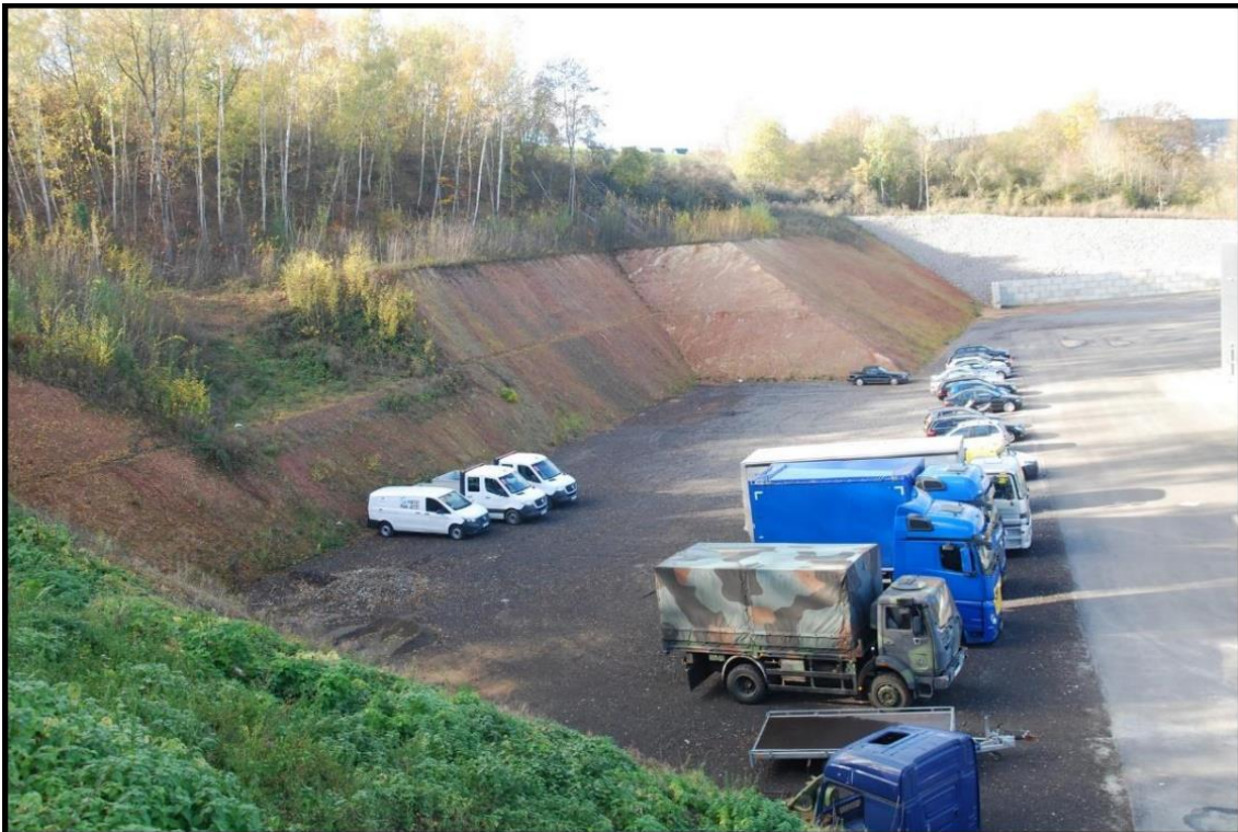
Abbildung 3: Darstellung IST Zustand 11.2021 nach Rodung und Erdarbeiten – Blick von Osten (...)
