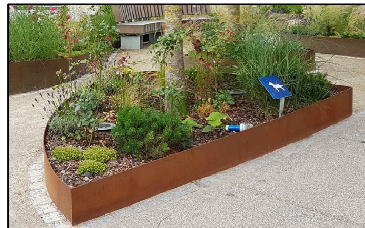
Alternative Einfassung mit Cortenstahl
