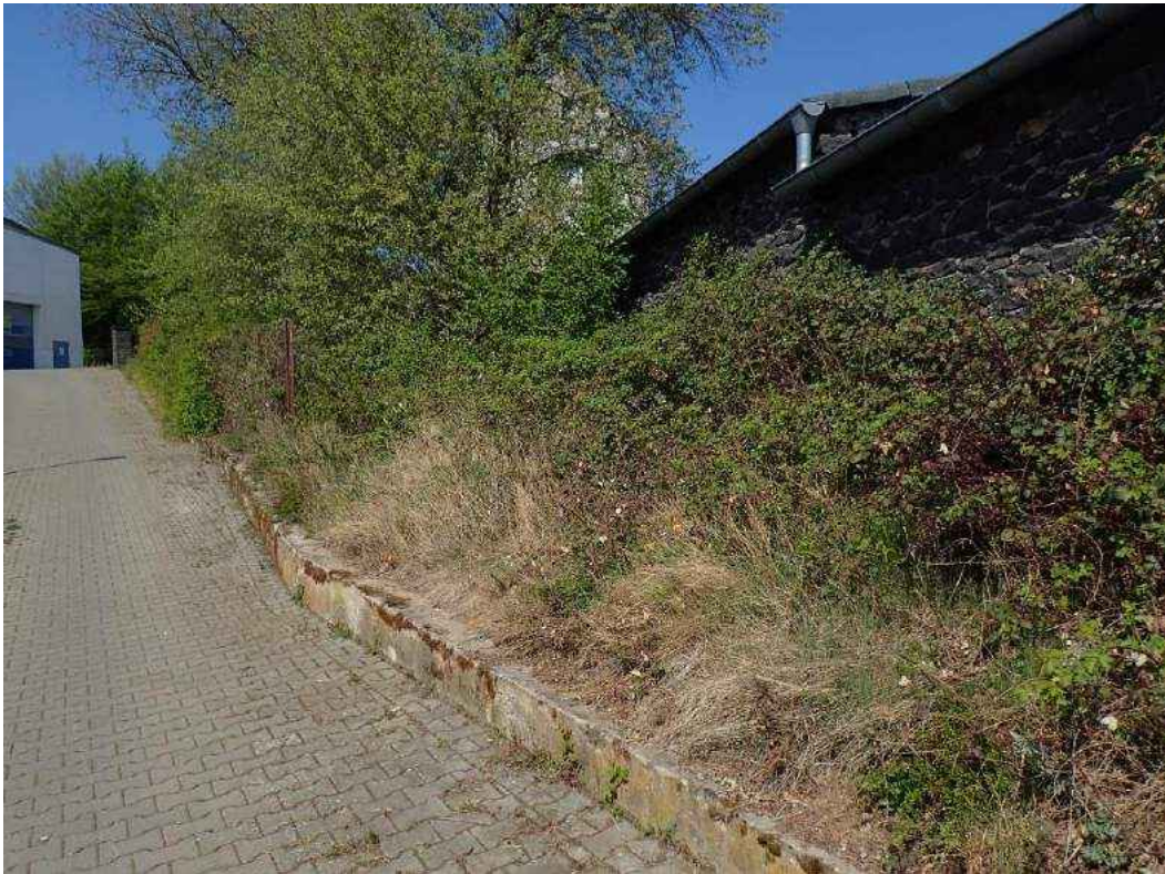
Bild 25: Übergangsbereich zwischen den Parz. 435/19 und 435/36 mit einem begleitenden Gehölzstreifen im nördlichen Teil, der Südteil wird von Gebäuden begrenzt
