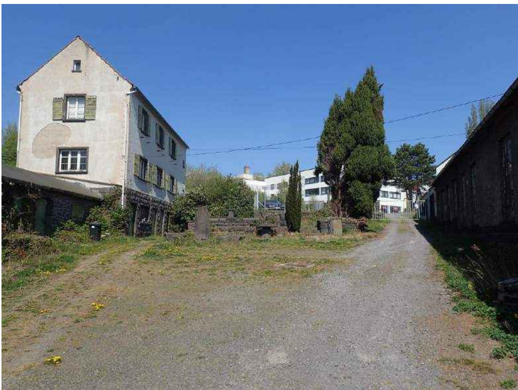
Bild 08: Zugangsbereich des Firmengeländes Schlink KG im südlichen Teil des Vorhabensgebietes
