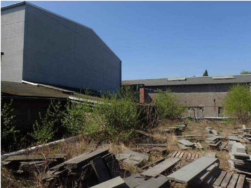
Bild 11: Lagerbereiche mit unterschiedlichen Materialien und Teilbereichen mit Gehölzaufwuchs
