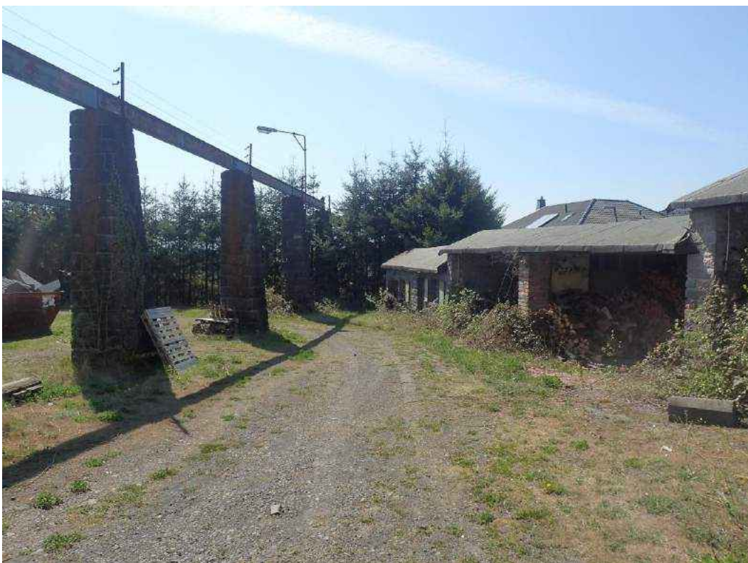
Bild 10: Gebäudestrukturen am westlichen Rand von Flurstück 435/19 südlich des Kottenheimer Wegs
