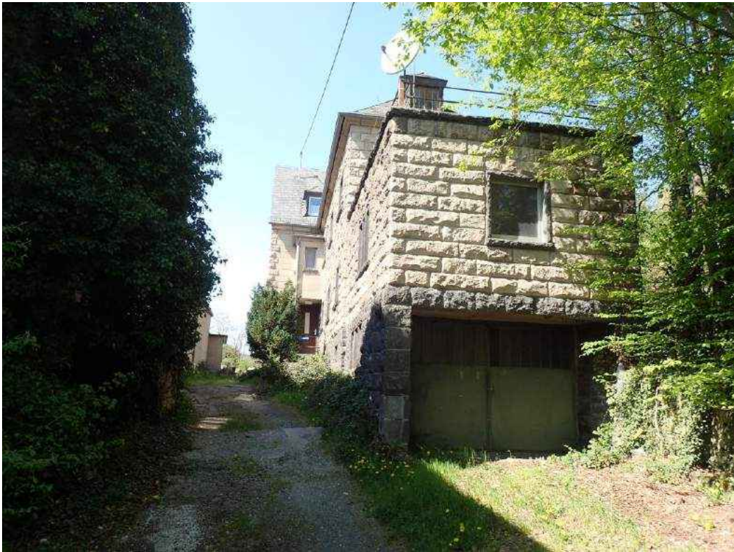
Bild 17: Gebäudestrukturen und ein stark beschatteter, schmaler Durchgang im westlichen Teil des Geländes der SHS Naturstein GmbH
