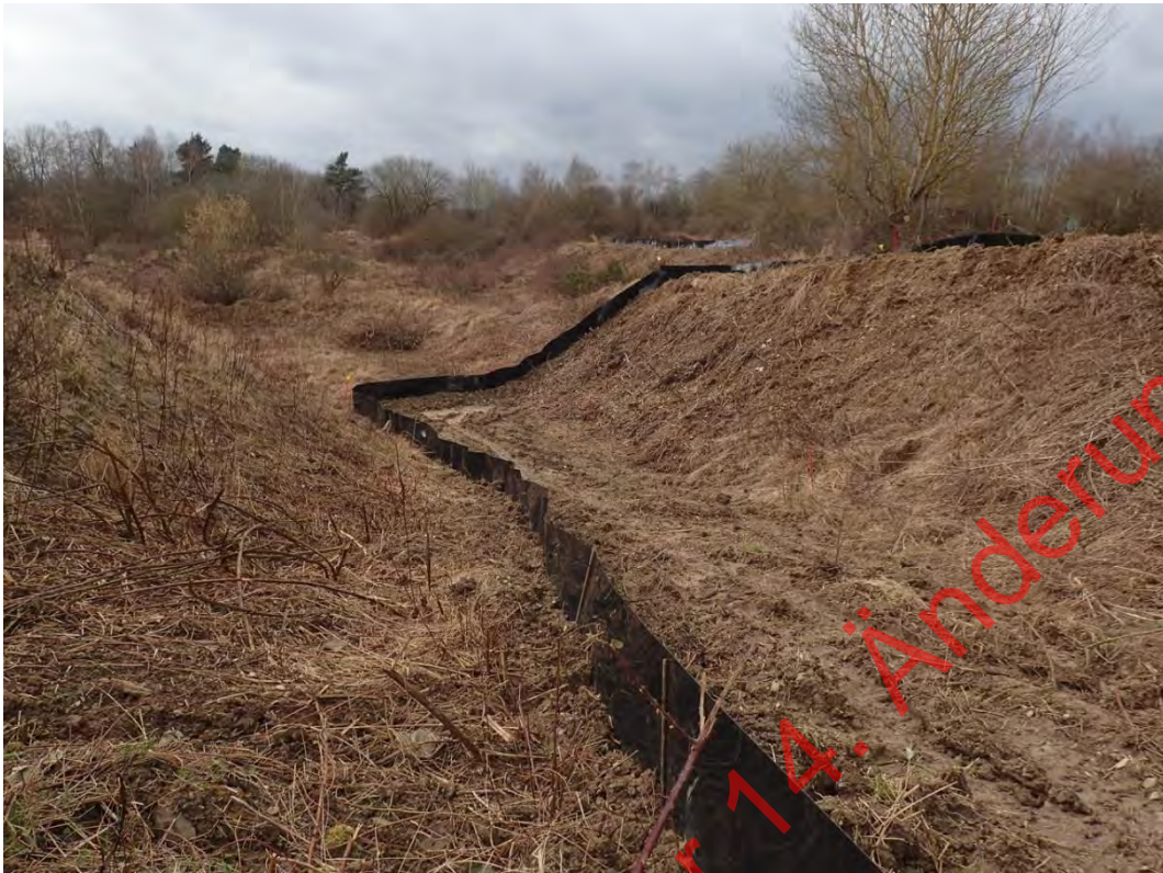
Bild 16: Fertig gestellte Rhizomsperr im Grubenbereich (24.02.2022)
