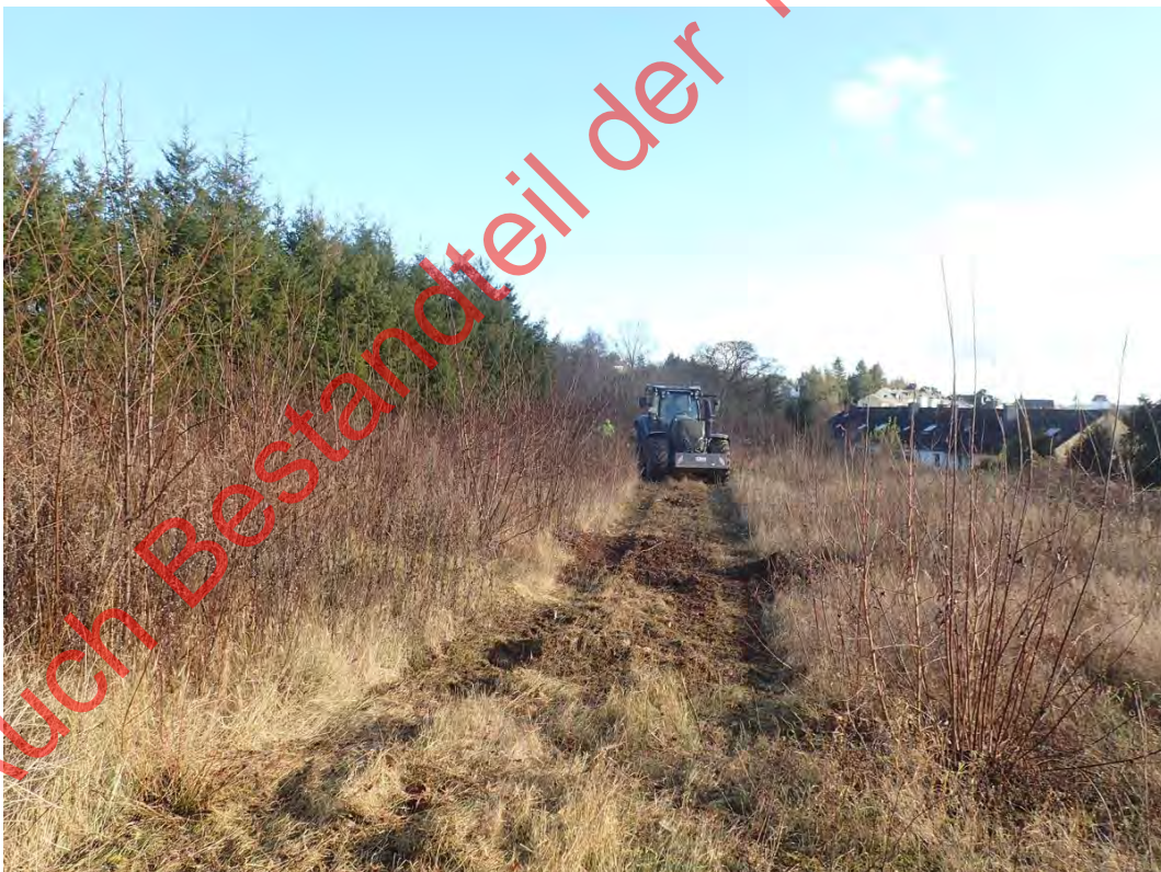
Bild 03: Rodung der zuvor entsprechend markierten Gehölzbestände im Eingriffsbereich (20.12.2021)
