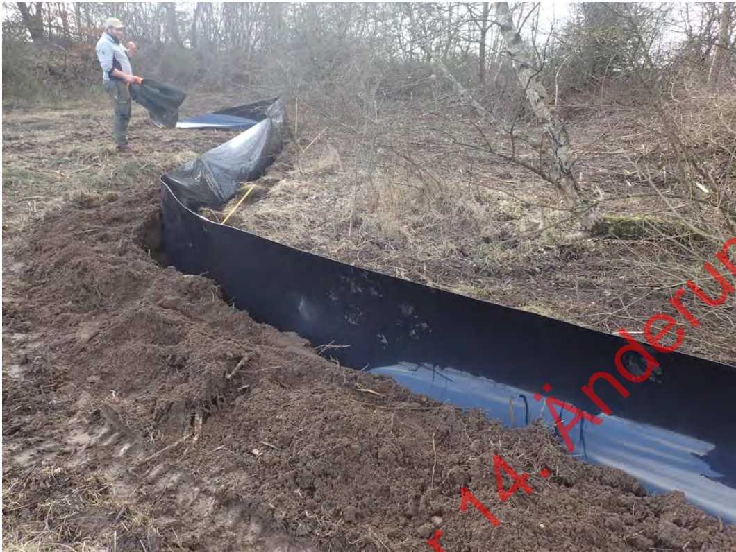
Bild 14: Einsetzen der Rhizomsperre (02.02.2022)
