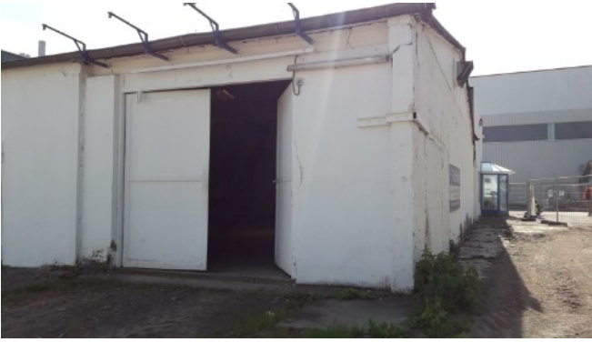
Abbildung 5: Ungenutzte Halle im Südteil der TF1
