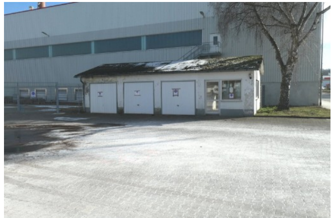
Abbildung 8: Altes Pförtnerhäuschen in TF1
