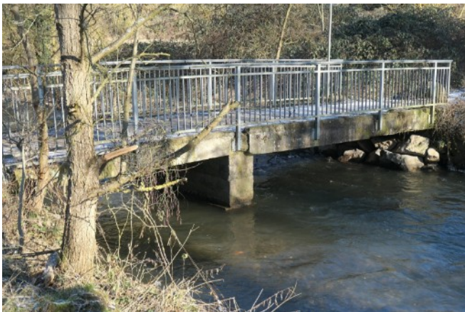
Abbildung 13: TF3, Fußgängerbrücke über die Nette
