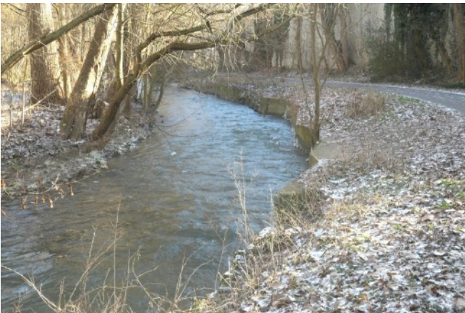
Abbildung 21: Nette mit betonierter Uferbefestigung
