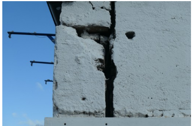
Abbildung 31: Mauerriß, Detail
