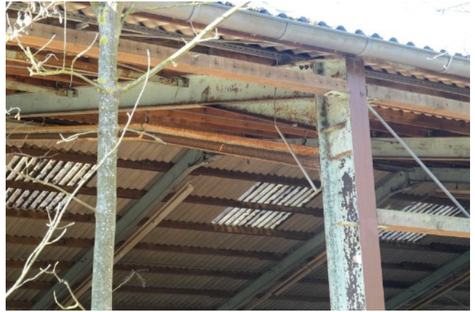
Abbildung 16: Detailansicht der Hallenkonstruktion
