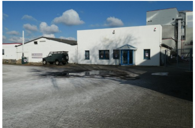
Abbildung 6: Hallenkomplex im Südteil der TF1
