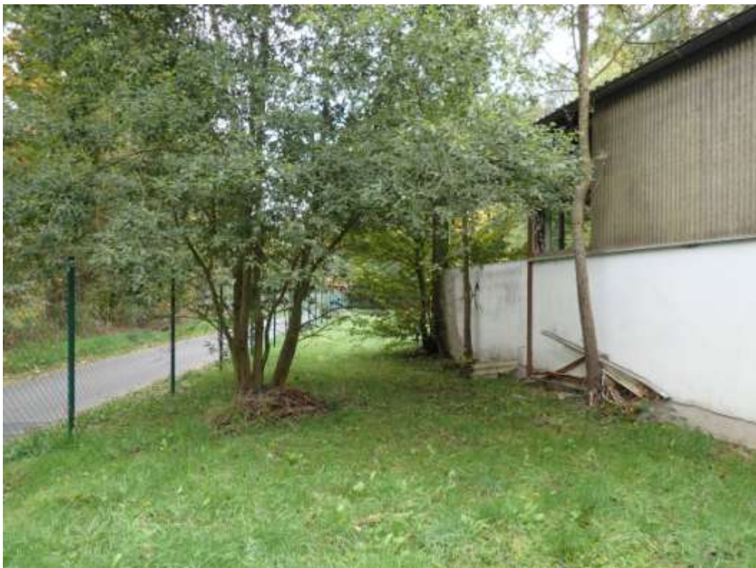
Bild 20: Die nordöstliche Gebäudesseite und der Fahrradweg (Blickrichtung Südosten)
