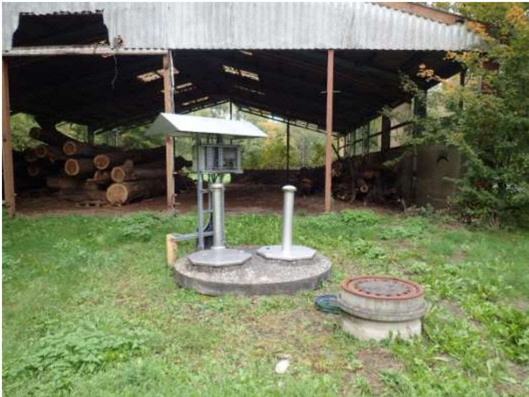
Bild 19: Brunnenkopf östlich der Reithalle
