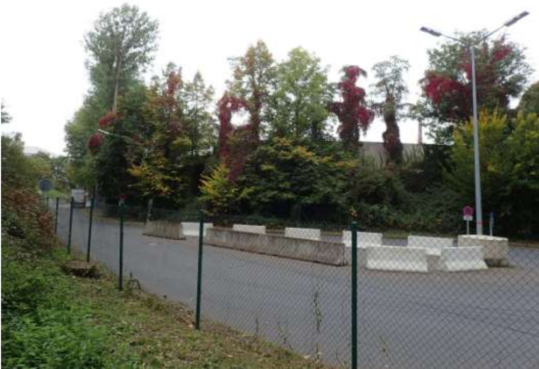
Bild 48: Die Verkehrinsel und die Lärmschutzwand im Hintergrund, Blickrichtung Südwesten
