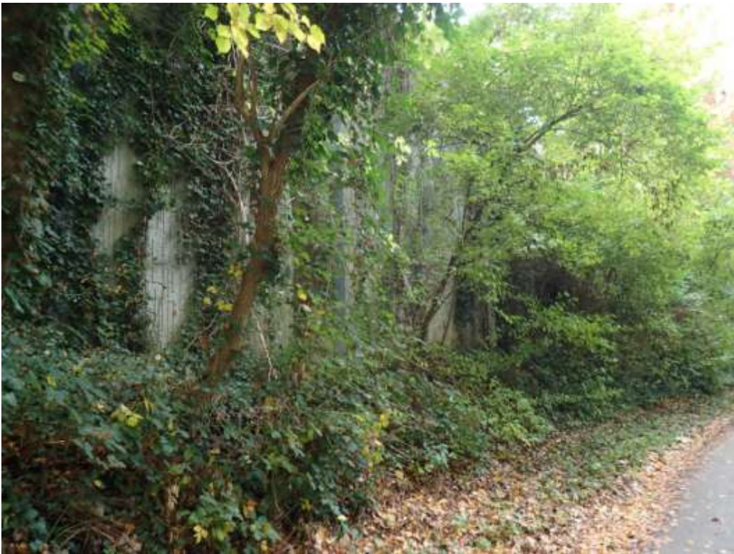
Bild 37: Bestehende Lärmschutzwand, teilweise mit Efeu ( Hedera helix ) bewachsen
