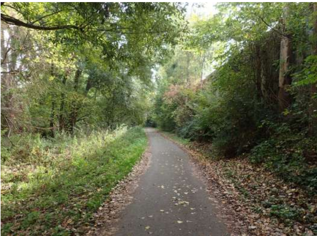
Bild 30: Die Lärmschutzwand südlich des Wirtschafts- und Radweges, links die Uferbereiche der Nette und vorgelagert der ehemalige Mühlgraben
