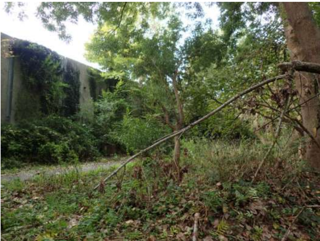
Bild 38: Blick auf die Lärmschutzwand
