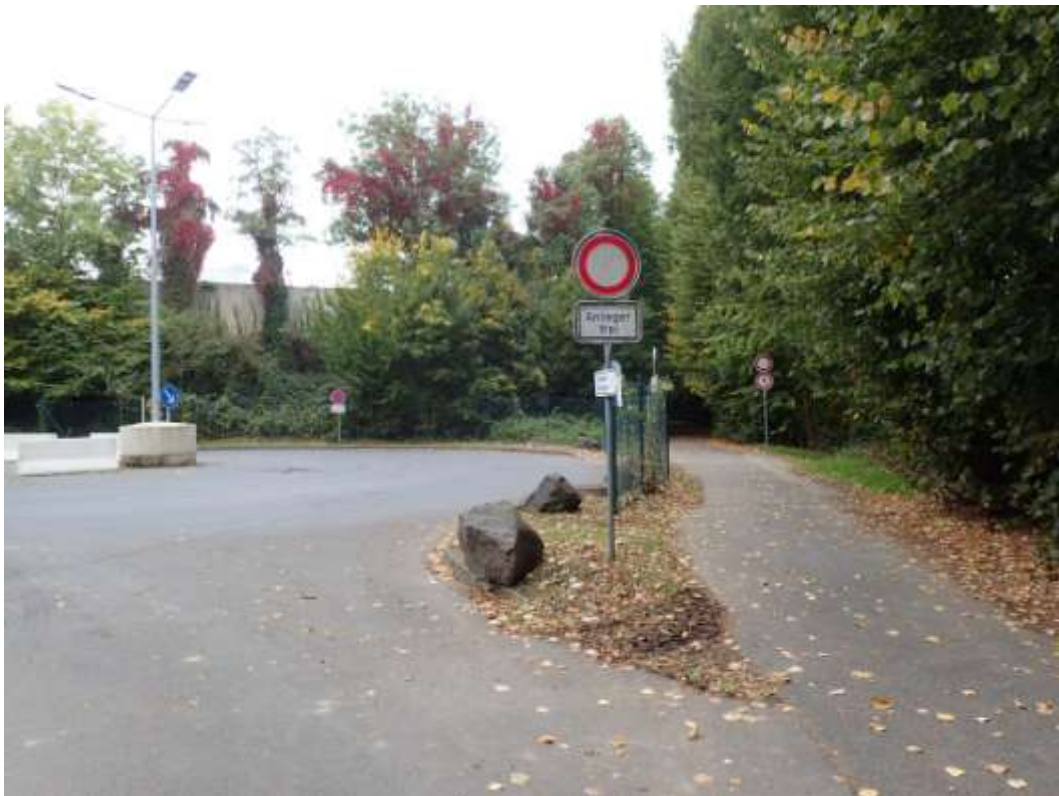
Bild 46: Der Wendehammer und der Fahrradweg, Blickrichtung Westen
