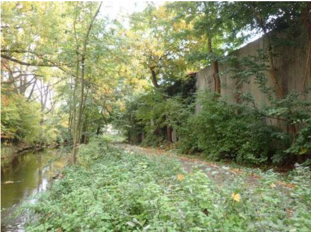
Bild 29: Blick auf die bestehende Lärmschutzwand nördlich des Firmengeländes der Fa. Weig, welche im Rahmen der Planung versetzt werden soll
