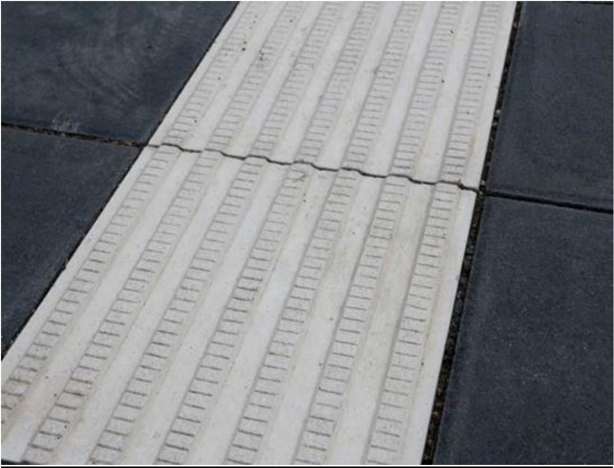
Beispielfoto Blindenleitelement als Rillenplatte nach DIN 32984.
