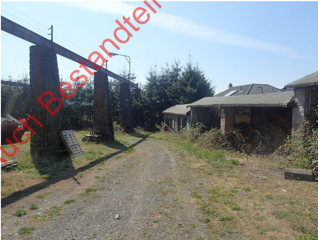
Bild 20: Reich strukturierte Fläche im Südosten des Gebietes
