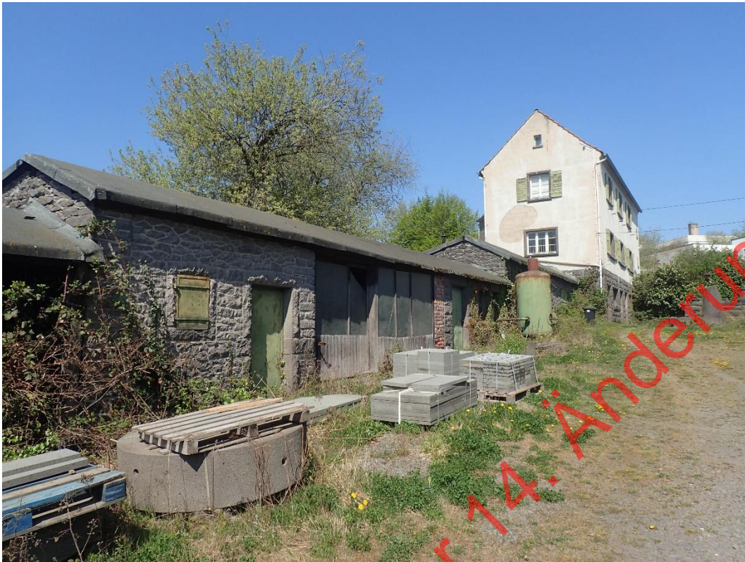
Bild 15: Gebäude auf der südöstlichen Fläche
