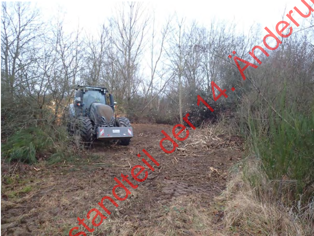
Bild 09: Gehölzbeseitigung mittels Forstmulcher (20.12.2022)
