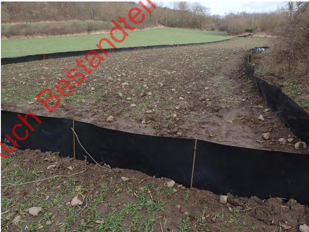
Bild 15: Fertig gestellte Rhizomsperre auf der Ackerfläche (24.02.2022)
