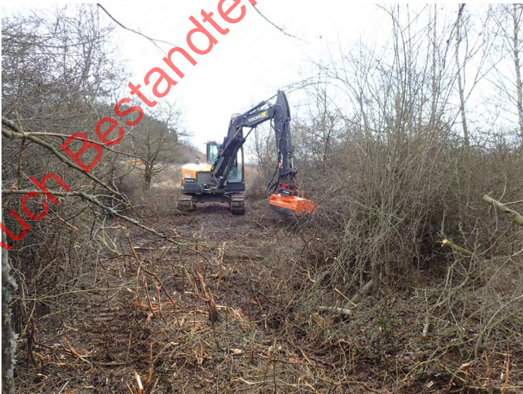
Bild 11: Anlage von Schneisen zum Stellen des Reptilienzauns
