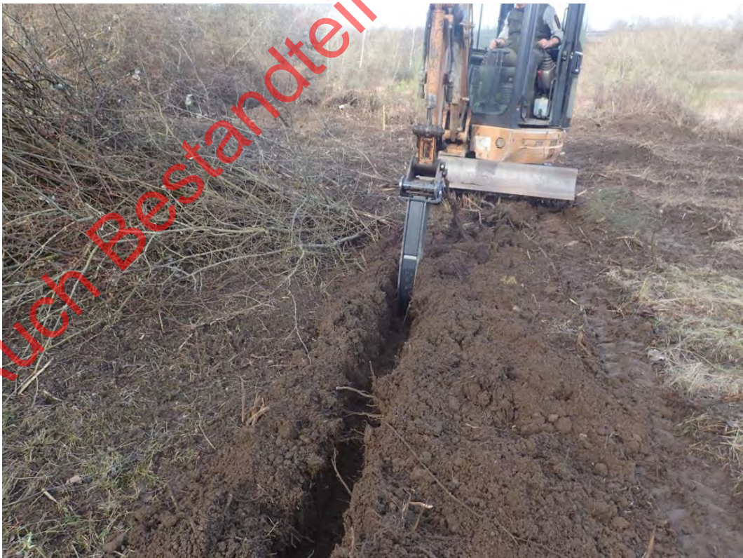
Bild 13: Ziehen einer Furche zum Einlassen der Rhizomsperre (02.02.2022)
