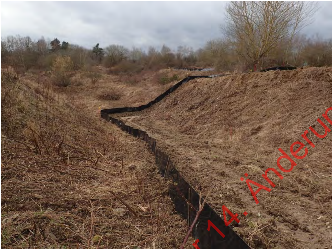
Bild 16: Fertig gestellte Rhizomsperre im Grubenbereich (24.02.2022)
