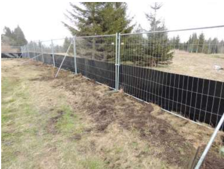
Abbildung 6 Reptilienschutzzaun aus Rhizomsperre vom Baufeld aus gesehen
