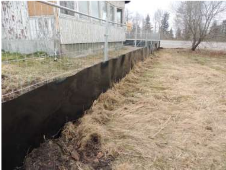
Abbildung 6 Reptilienschutzzaun aus Rhizomsperre von außerhalb gesehen
