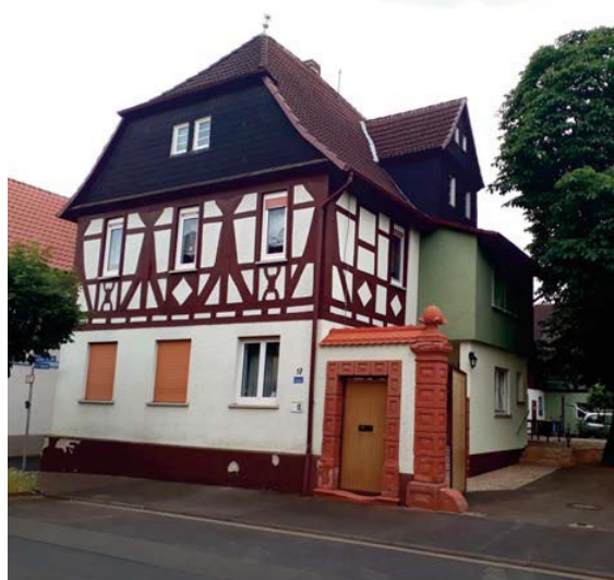
Fachwerkwohnhaus Hofgut Licher Str.17
