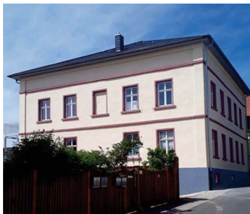
Saniertes Herrenhaus (Södel)
