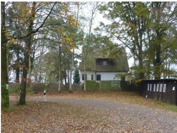
Abb. 1: Nördliche Grundstücksseite (Zufahrt)
