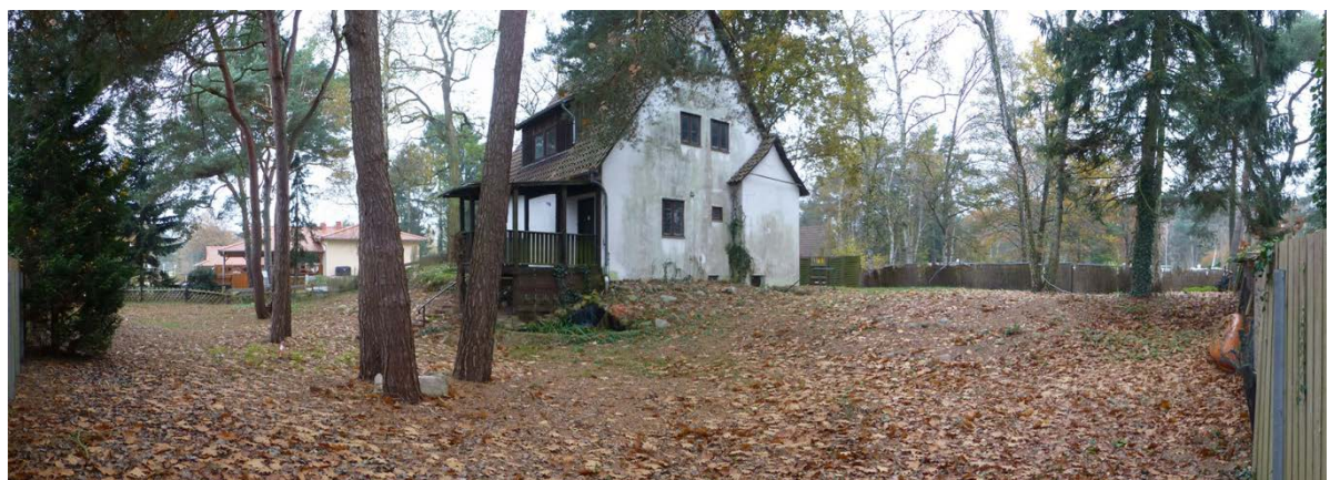
Abb. 3: Blick von der Süd-Ost-Ecke über das Grundstück (Fotos: Henckel 10/2014)
