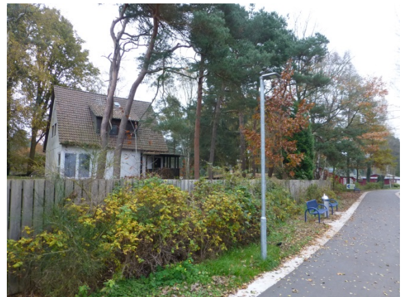
Abb. 2: Südliche Grundstücksseite (Uferweg)
