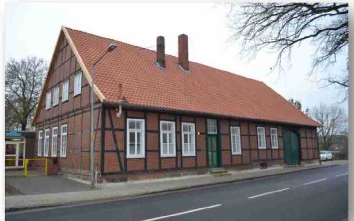
Das Gebäude nach der Dachsanierung
