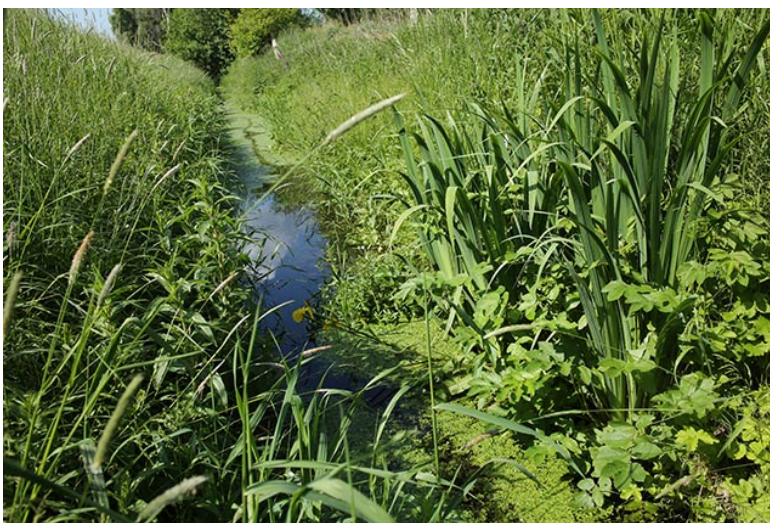
Abb. 11 Bedingt naturnaher Graben: Trapezprofil, Ufervegetation
